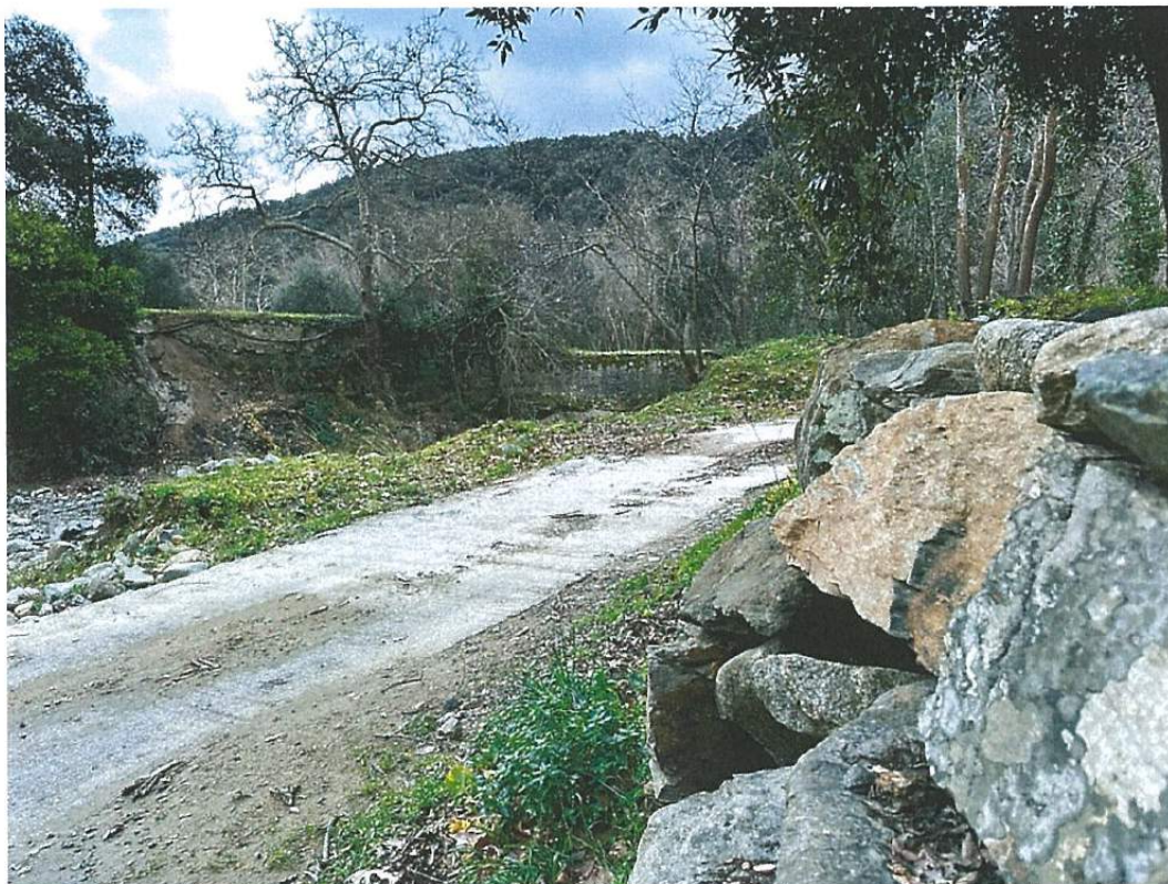
Εικόνα 10- Θέση έναρξης κατασκευής τοίχου αντιπλημμυρικής προστασίας στο δυτικό πρηνές του ποταμού
