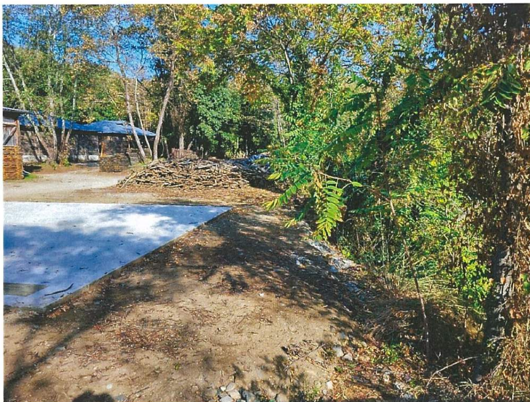
Εικόνα 16. Φρύδι πρανούς πλησίον γέφυρας.
