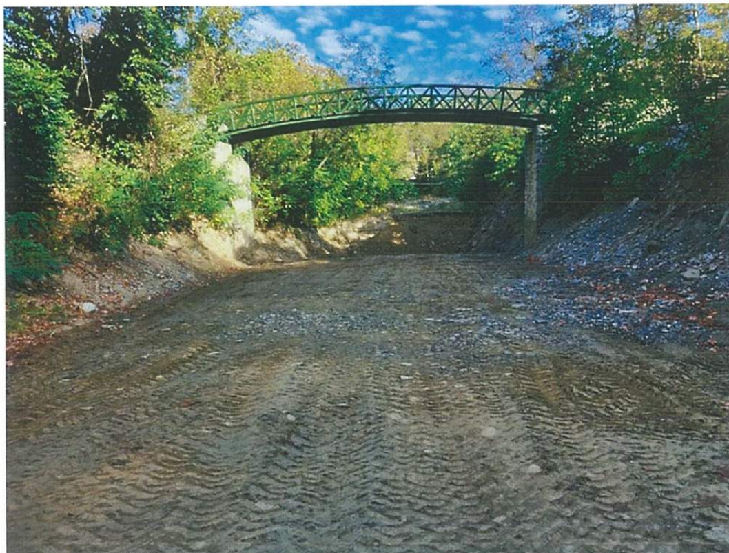
Εικόνα 11- Βάθρο πεζογέφυρας, Σημείο ένωσης των τμημάτων του τοίχου αντιστήριξης με το βάθρο γέφυρας
