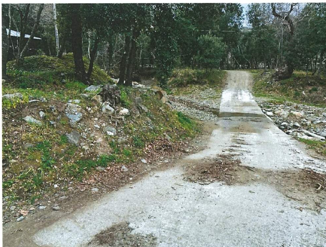
Εικόνα 17. Θέση διασταύρωσης των δύο ρεμάτων
