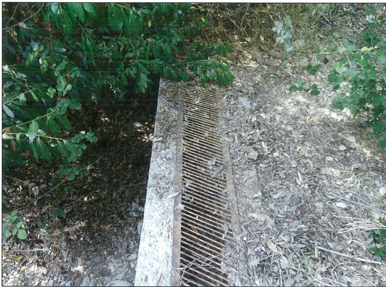
Φωτ. 3 : Φρεάτιο εισόδου στη θέση του ρέματος.
