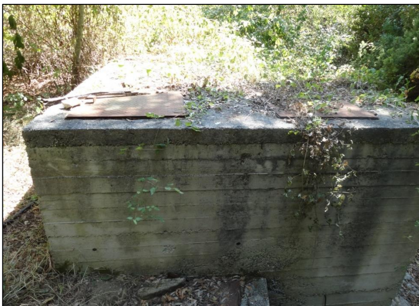
Φωτ. 2 : Φρεάτιο υδροληψίας στην θέση του ρέματος.
