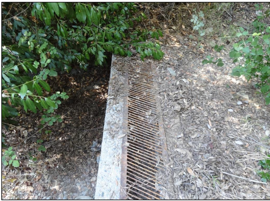
Φωτ. 1 : Φρεάτιο εισόδου στην θέση του ρέματος.
