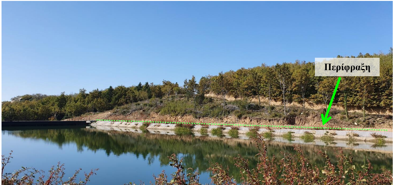
Εικόνα 2. Θέση κατασκευής περίφραξης ταμιευτήρα
