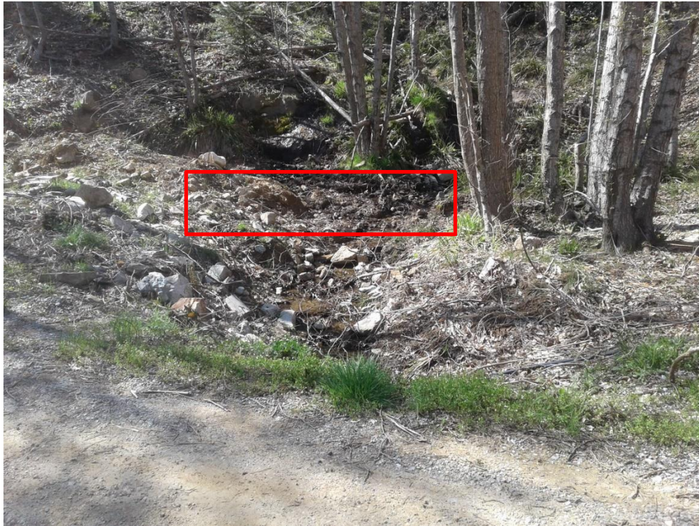
Εικόνα 10. Θέση 2 κατασκευής φρεατίου
