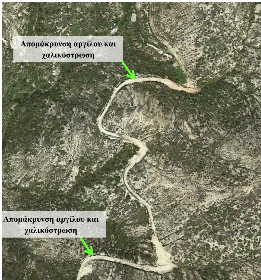
Εικόνα 5. Δορυφορική απεικόνιση τμήματος εργασιών (Google Earth)
