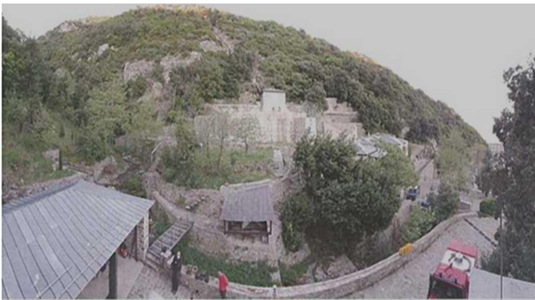
Πανοραμική άποψη της θέσης ανέγερσης της δεξαμενής, από δυτικά . Διακρίνεται το ανάγλυφο της περιοχής μελέτης καθώς και το σύνολο των κατασκευών της ευρύτερης περιοχής.(αναλήμματα, δεξαμενές, υδατογεννήτρια, στέγαστρο)
