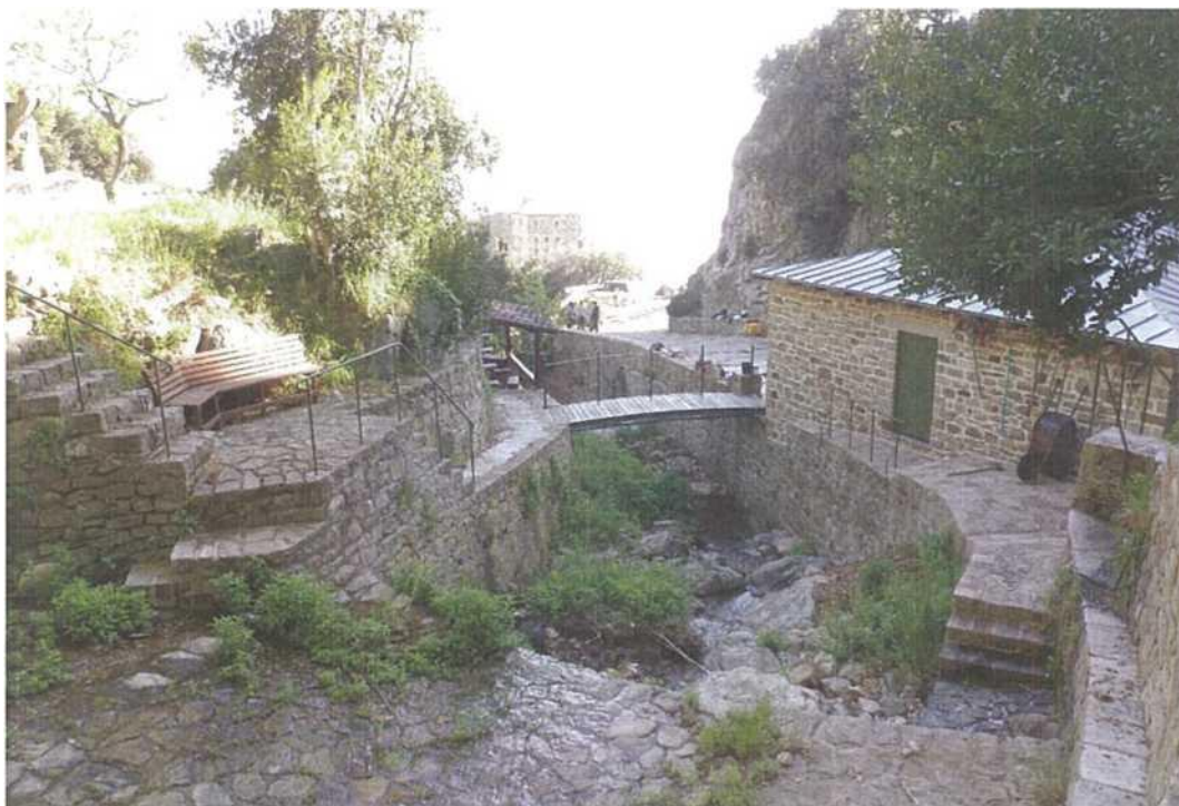
Άποψη του ρέματος, από βόρεια. Διακρίνεται στα αριστερά το πατάρι χωροθέτησης της δεξαμενής.
