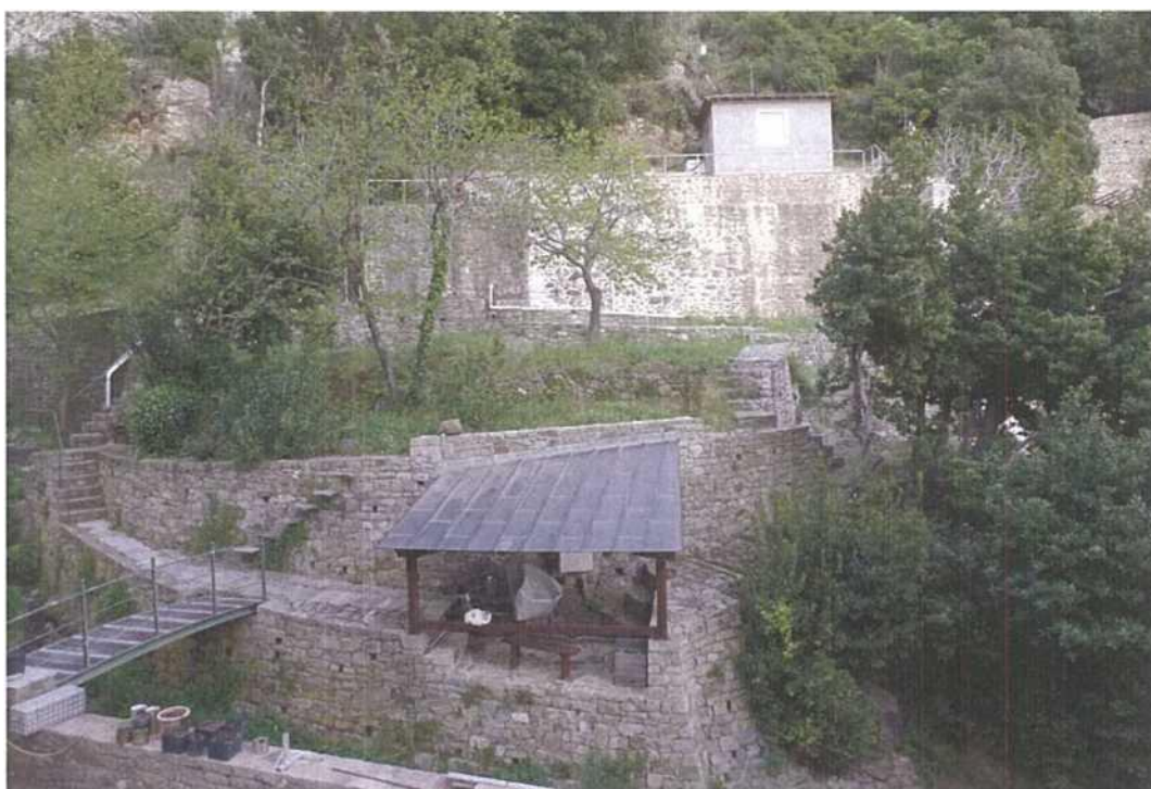
Άποψη της θέσης ανέγερσης της δεξαμενής, από δυτικά. Χαμηλά διακρίνεται το ρέμα.
