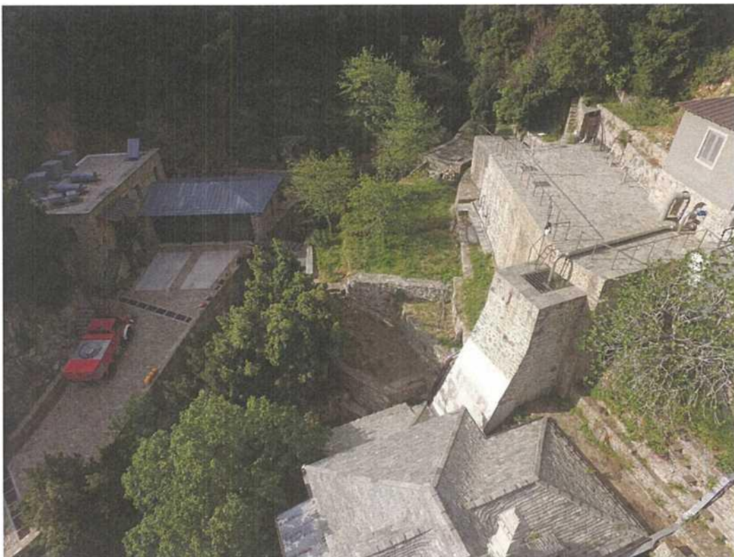
Πανοραμική άποψη της θέσης ανέγερσης της δεξαμενής, από νότια.
