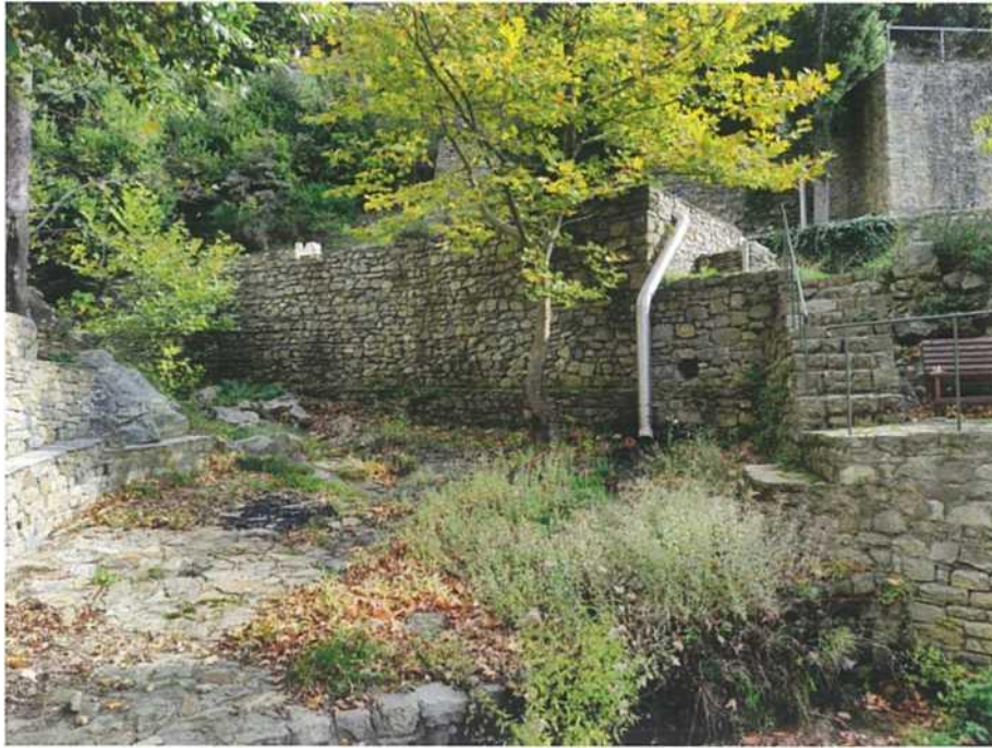
Εικόνα.4 Δυτική όψη υφιστάμενης δεξαμενής
