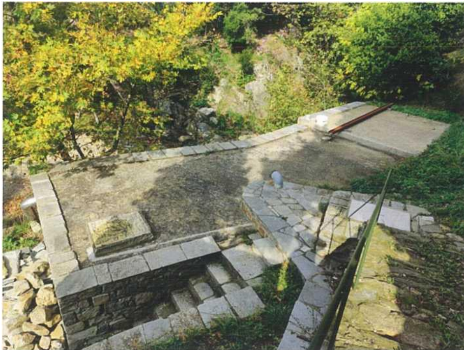
Εικόνα.2 Δώμα υφιστάμενης δεξαμενής
