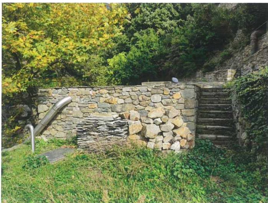
Εικόνα.3 Νότια όψη υφιστάμενης δεξαμενής
