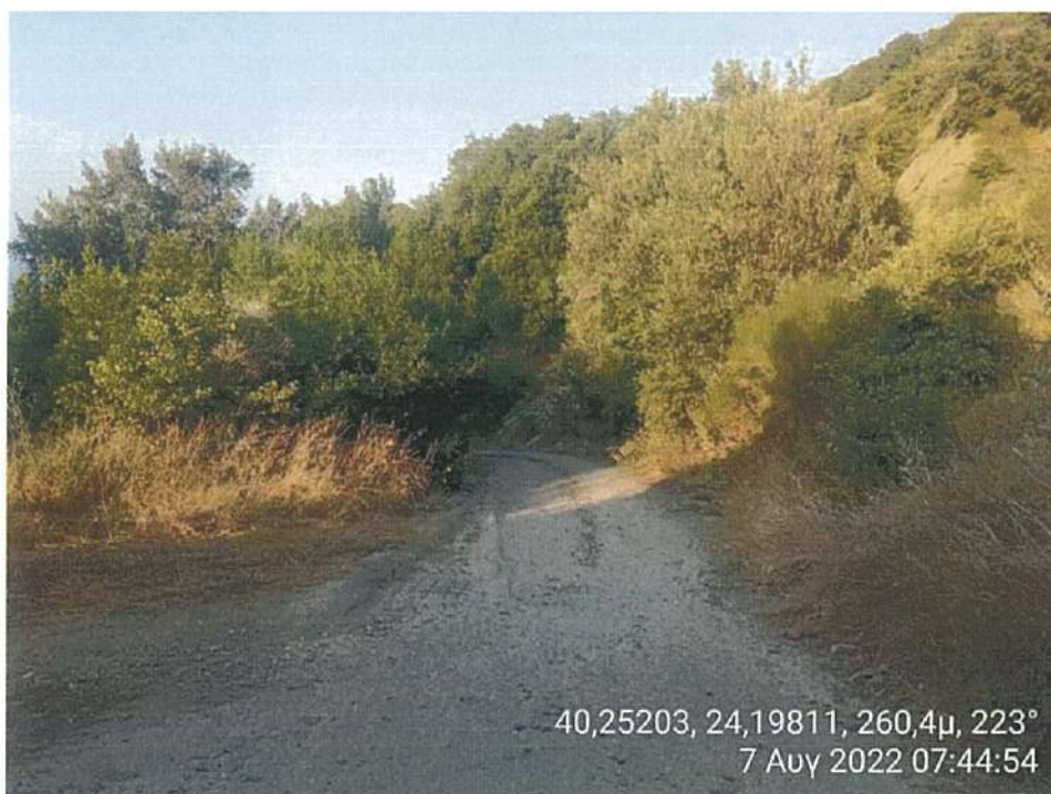
Φωτογραφία 10. Τμήμα του δρόμου προς αποκατάσταση
