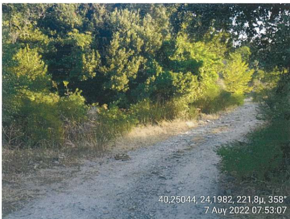
Φωτογραφία 18. Τμήμα του δρόμου προς αποκατάσταση
