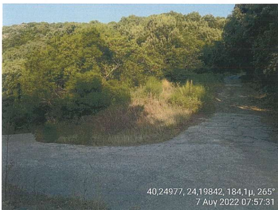
Φωτογραφία 20. Τμήμα του δρόμου προς αποκατάσταση
