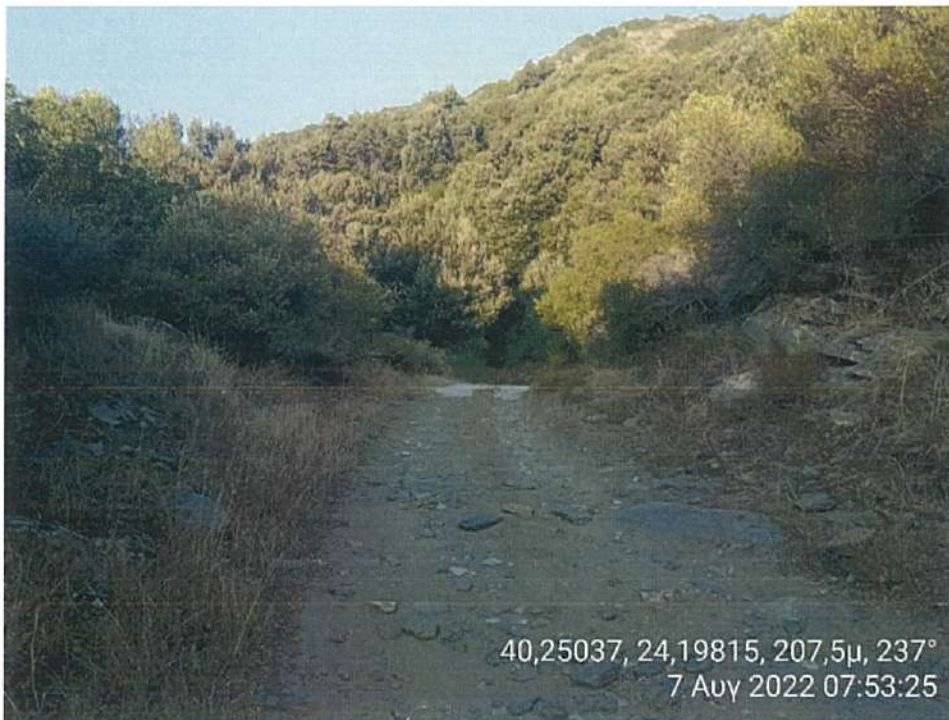
Φωτογραφία 17. Τμήμα του δρόμου προς αποκατάσταση
