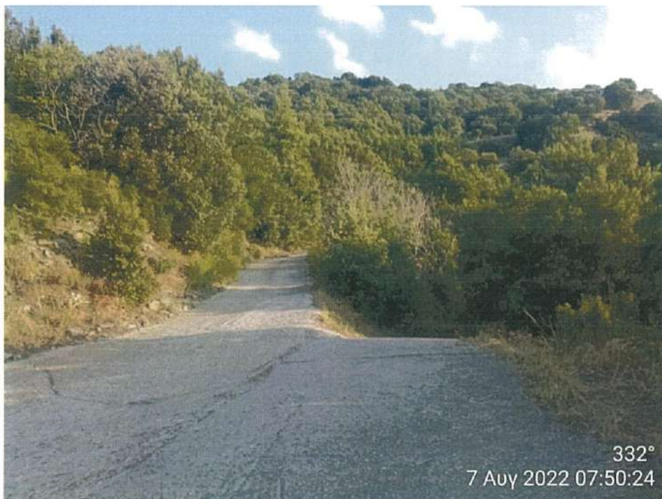
Φωτογραφία 14. Τμήμα του δρόμου προς αποκατάσταση
