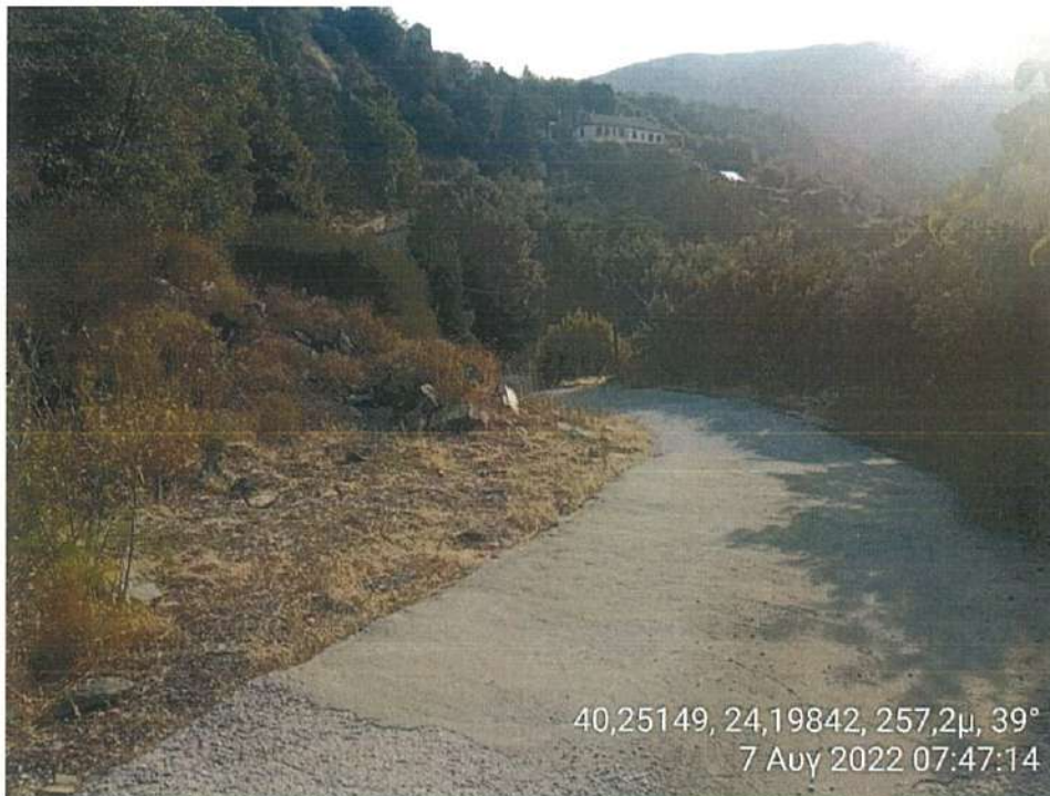
Φωτογραφία 11. Τμήμα του δρόμου προς αποκατάσταση
