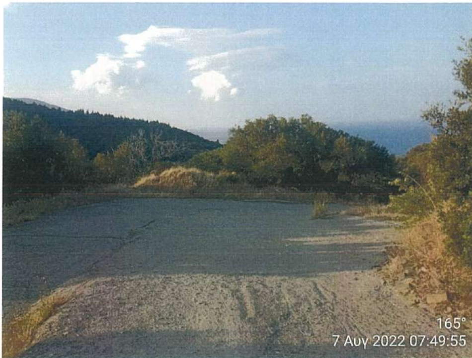
Φωτογραφία 13. Τμήμα του δρόμου προς αποκατάσταση
