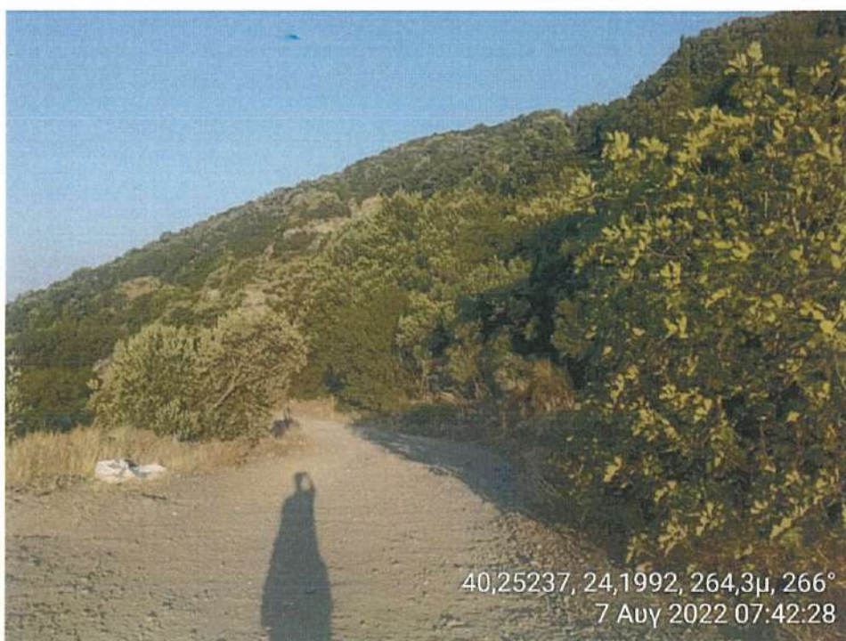
Φωτογραφία 8. Τμήμα του δρόμου προς αποκατάσταση
