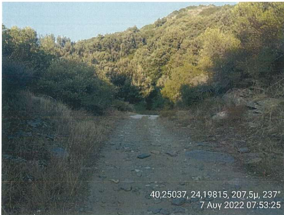
Φωτογραφία 19. Τμήμα του δρόμου προς αποκατάσταση
