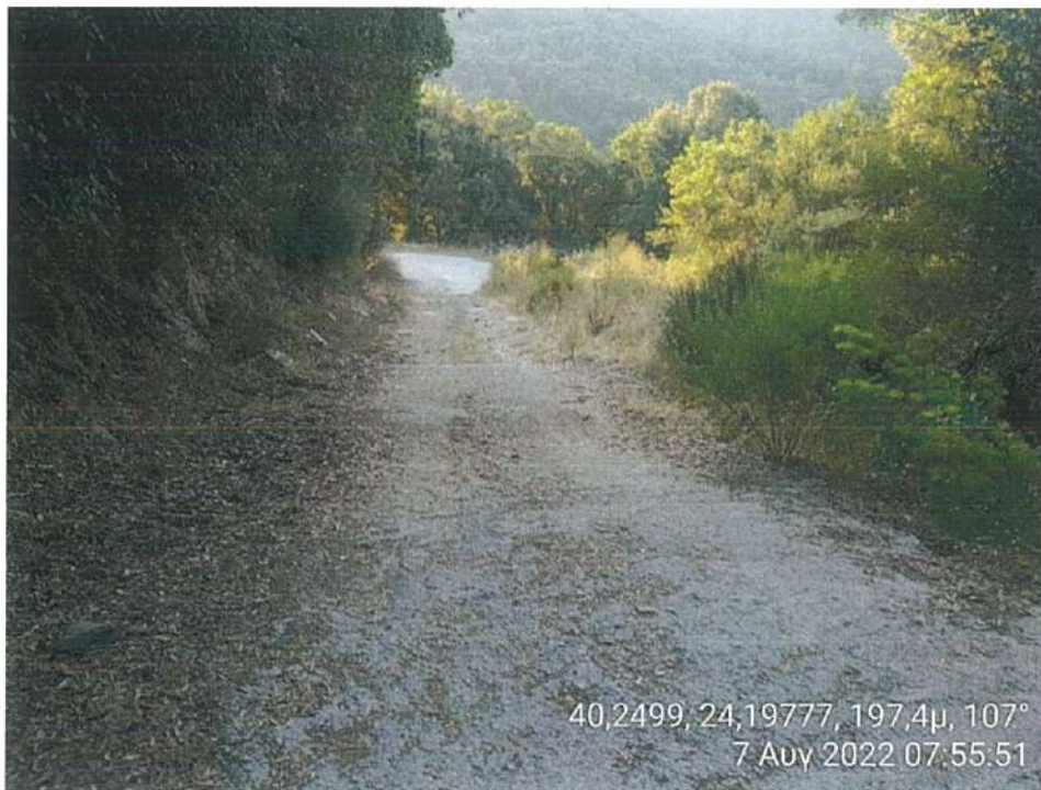
Φωτογραφία 19. Τμήμα του δρόμου προς αποκατάσταση
