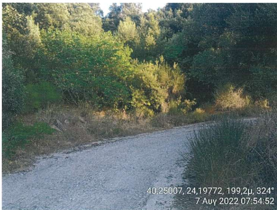
Φωτογραφία 20. Τμήμα του δρόμου προς αποκατάσταση
