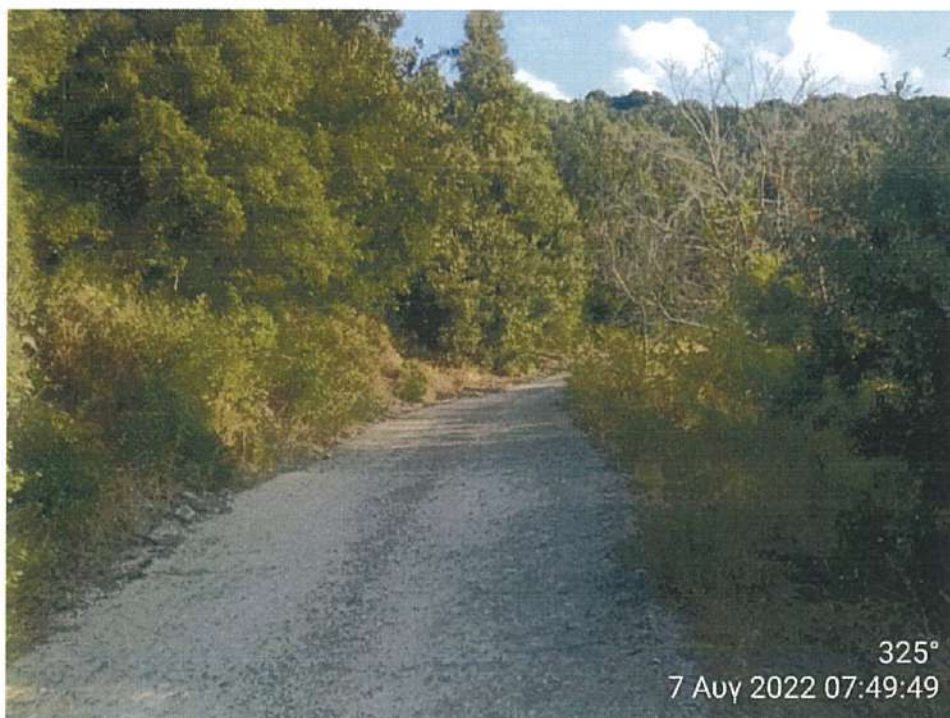
Φωτογραφία 12. Τμήμα του δρόμου προς αποκατάσταση
