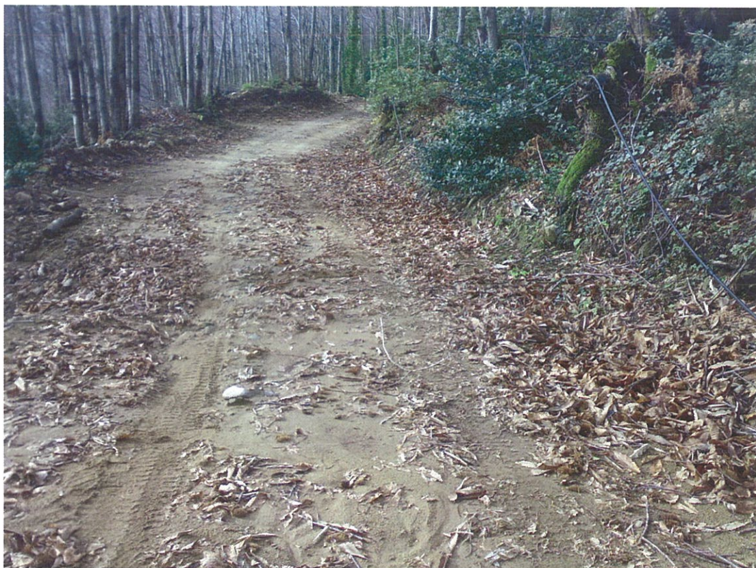
Φωτογραφία 1: Αρχή της πρώτης χωματοργικής παρέμβασης (X1). Διακρίνεται η έντονη ανωφέρεια (14,92%)
