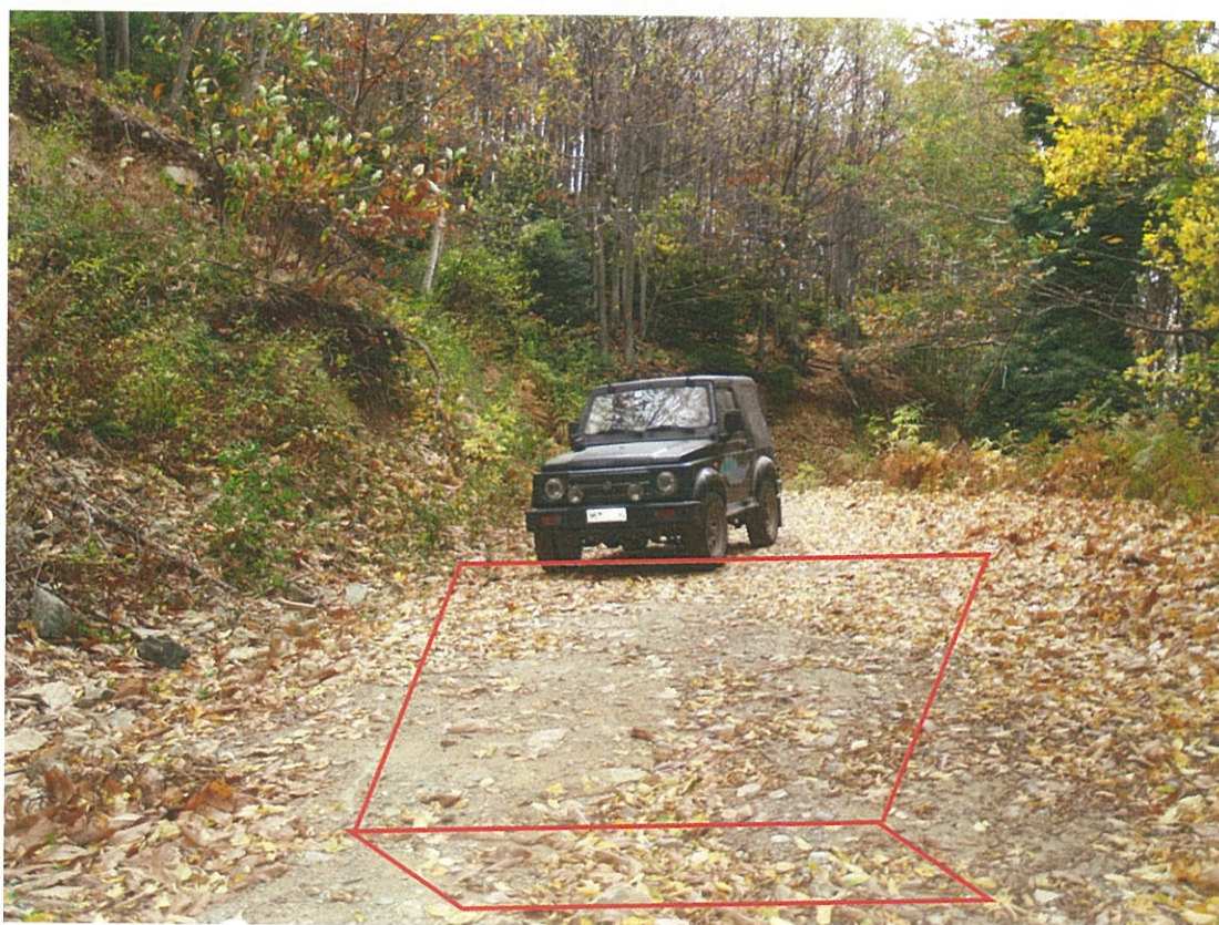
Φωτογραφία 16: Τεχνικό έργο 31 (Ρεϊθρο). Το τεχνικό απάγει τα επιφανειακά ύδατα και του δρόμου και του υπερκείμενου ρέματος και τα οδηγεί στα κατάντη.
