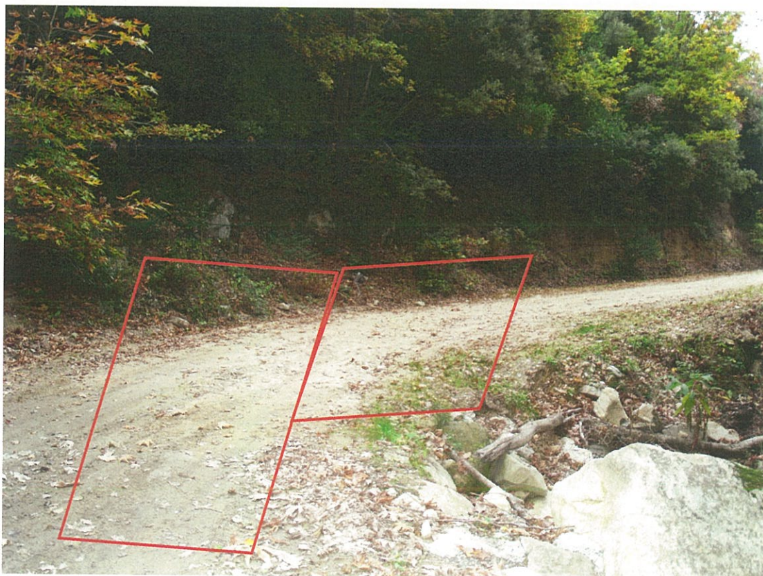
Φωτογραφία 10: Τεχνικό έργο 17 (Ρεϊθρο). Το τεχνικό απάγει τα επιφανειακά ύδατα του δρόμου και του ρέματος και τα οδηγεί στα κατάντη. Διακρίνεται η πλούσια βλάστηση της περιοχής μελέτης.
