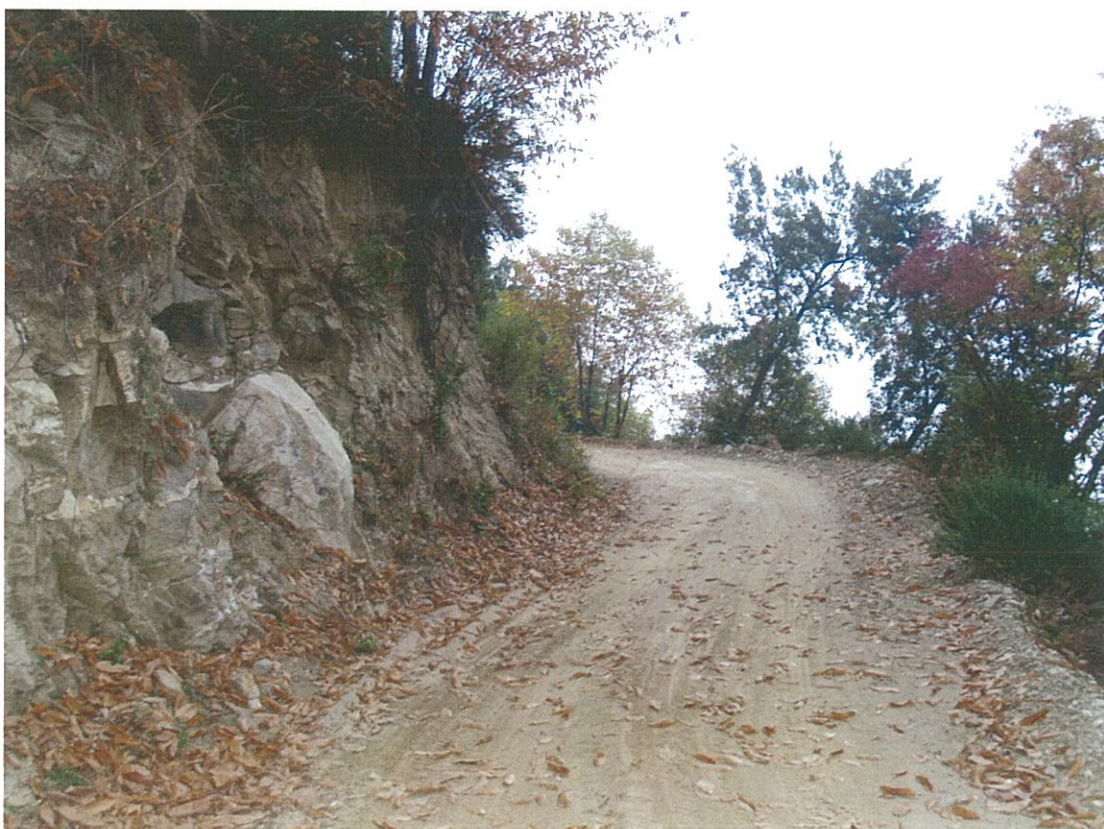
Φωτογραφία 2: Δεύτερη χωματοργική παρέμβαση (X2). Διαφαίνεται η μικρή ακτίνα καμπylότητας καθώς και το βραχώδες της περιοχής.
