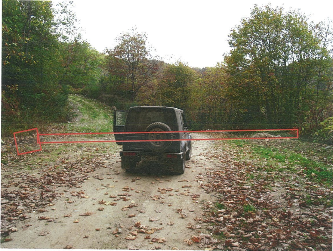
Φωτογραφία 11: Τεχνικό έργο 18 (Σωληνωτός οχετός με φρεάτιο). Το τεχνικό απάγει τα επιφανειακά ύδατα και των δύο δρόμων και τα οδηγεί στα κατάντη.
