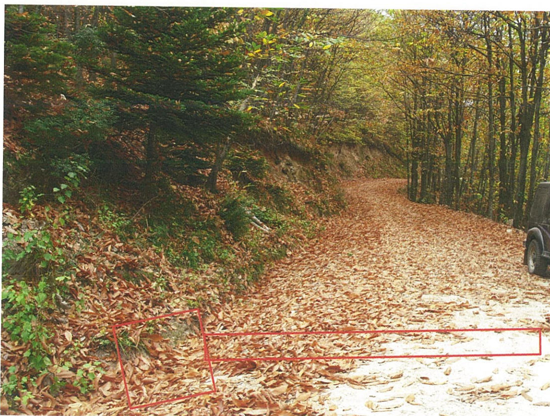
Φωτογραφία 14: Τεχνικό έργο 25 (Σωληνωτός οχετός με φρεάτιο). Το τεχνικό απαγει τα επιφανειακά ύδατα και του δρόμου και τα οδηγεί στα κατάντη.
