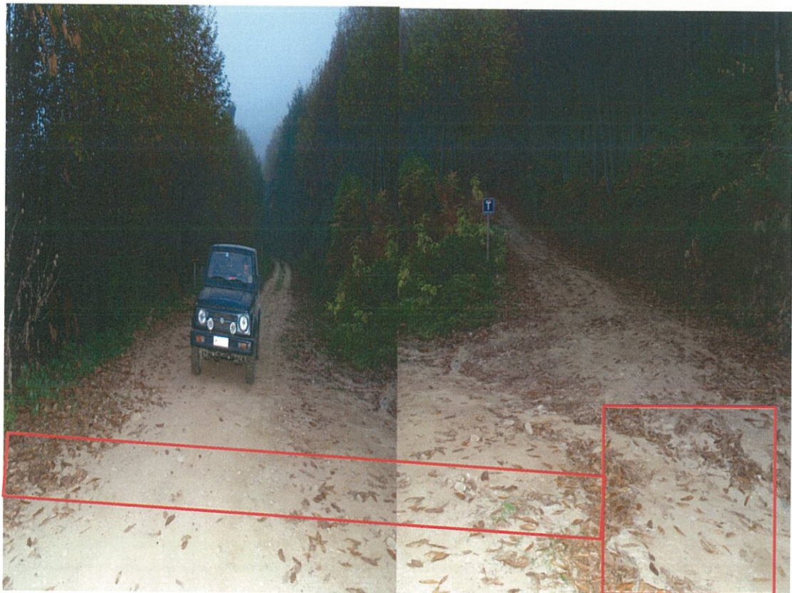
Φωτογραφία 4: Τεχνικό έργο 4 (Σωληνωτός οχετός με φρεάτιο). Το τεχνικό απαγει τα επιφανειακά ύδατα και των δύο δρόμων και τα οδηγεί στα κατάντη.
