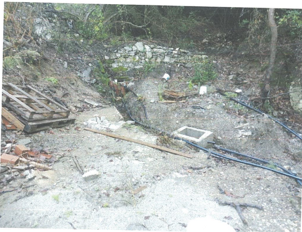
Εικόνα 1: Απεικόνιση της θέσεως όπου θα γίνουν έργα αποκατάστασης της λιθόκτιστης πρόσοψης της πηγής.
