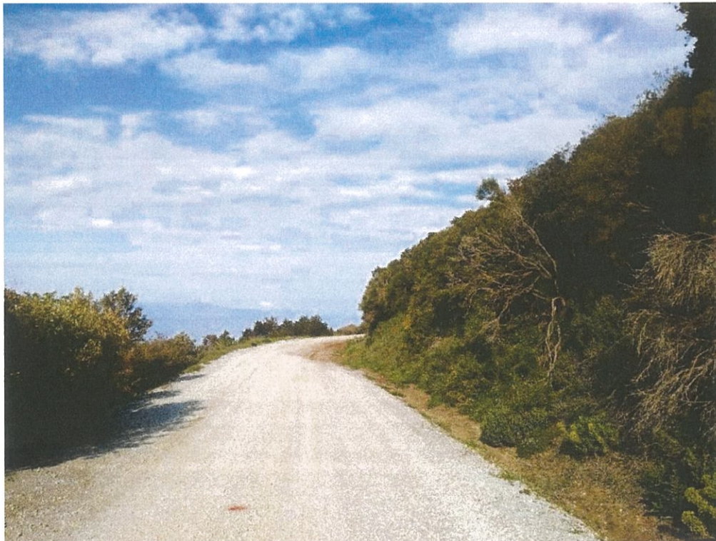
Φωτογραφία 2. Θέση κατασκευής οδοστρωσίας (θέση 5)
