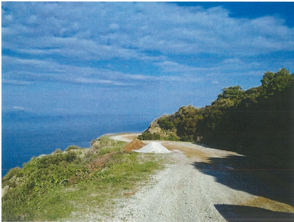
Φωτογραφία 3. Θέση τοποθέτησης μεταλλικών στηθαίων (Χ.Θ 0+445)
