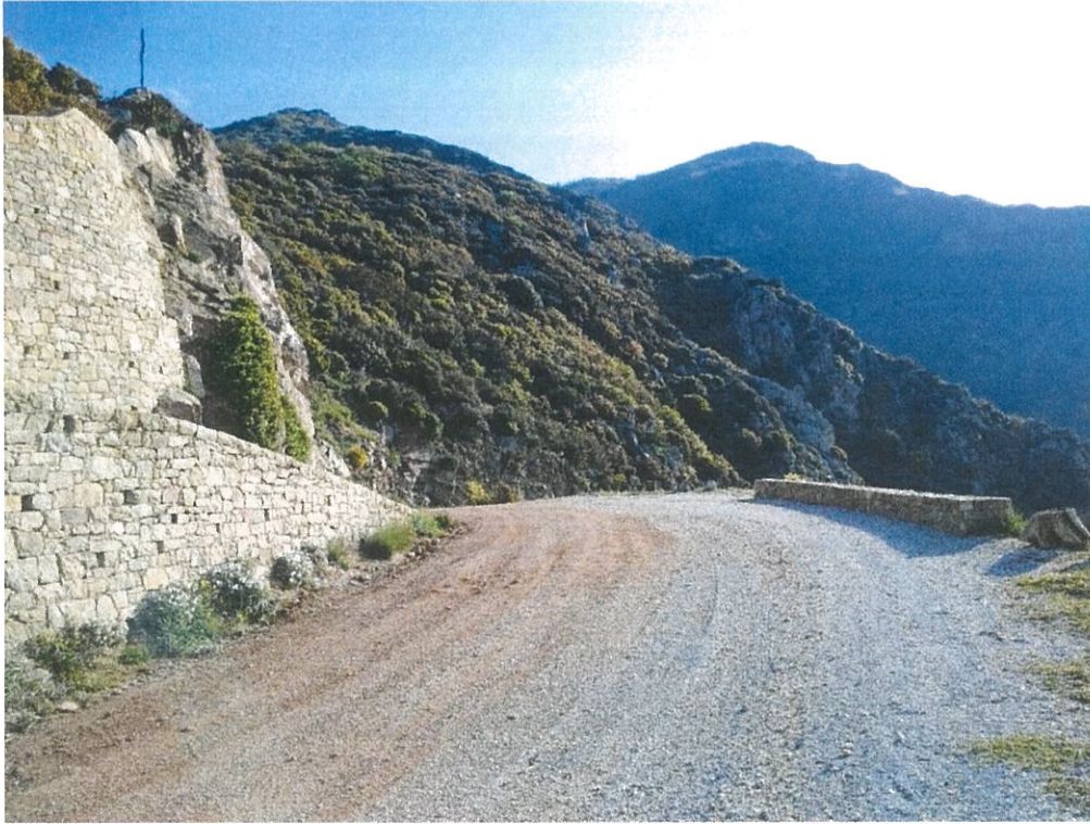
Φωτογραφία 1. Θέση κατασκευής οδοστρωσίας (θέση 1)
