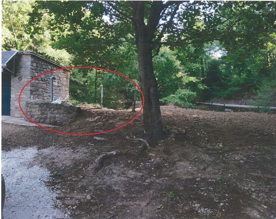
Εικόνα 9. Θέση υφιστάμενης δεξαμενής
