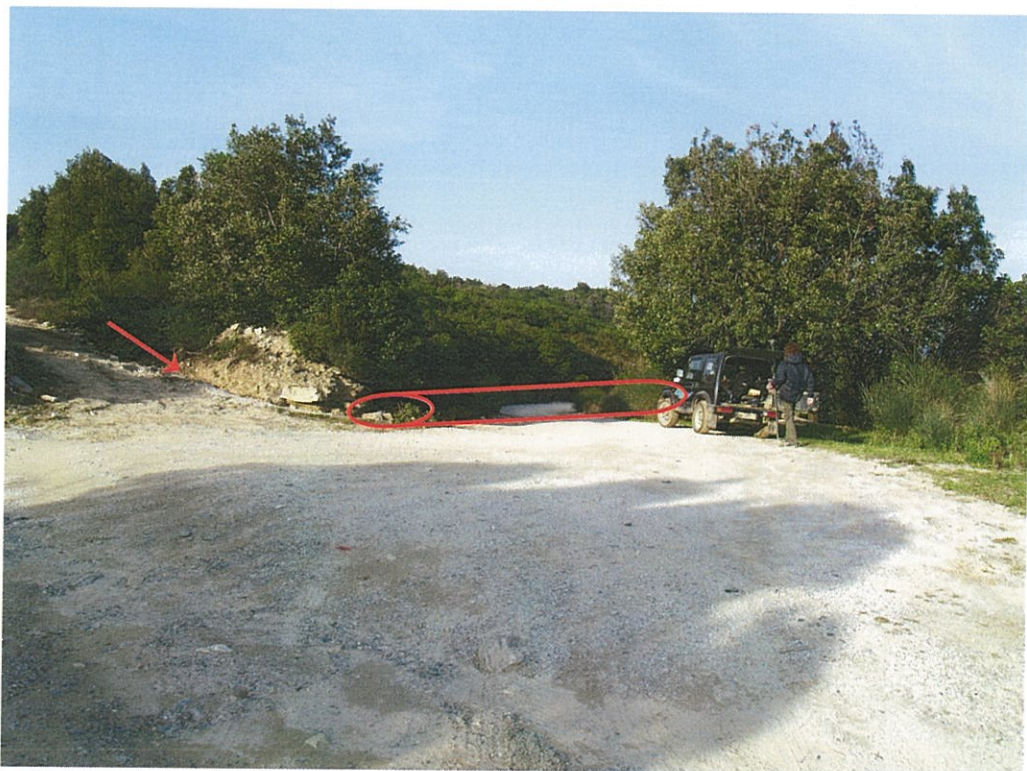
Φωτογραφία 2: Θέση κατασκευής του πρώτου τεχνικού (Δτ Π1). Το τεχνικό θα είναι σωληνωτός οχετός μήκους L=12\text{m} και D=1\text{m} και θα απάγει τα όμβρια από τον υπερκείμενο δρόμο που οδηγεί στο πυροφυλάκιο της Αγίας Σκέπης.
