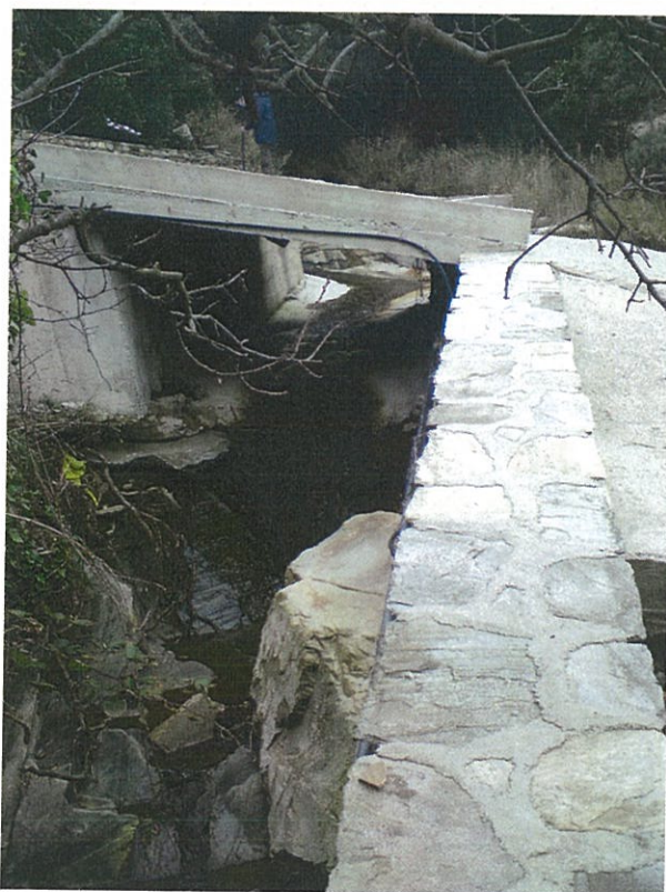
Φωτογραφία 14: Διατομή αποτύπωσης 173. Διακρίνεται η υφιστάμενη τσιμεντόστρωση καθώς και η μικρή γέφυρα που έχει κατασκευαστεί στη συγκεκριμένη θέση.
