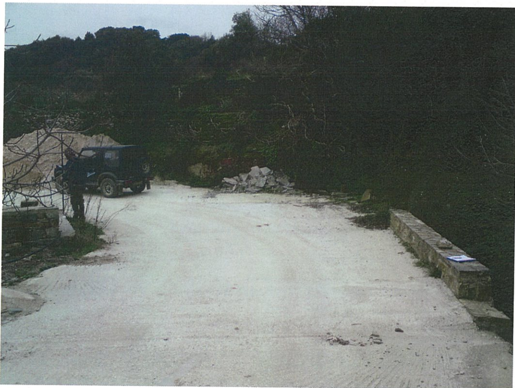
Φωτογραφία 12: Διατομή αποτύπωσης 152. Διακρίνεται η υφιστάμενη τσιμεντόστρωση καθώς και η μικρή γέφυρα που έχει κατασκευαστεί στη συγκεκριμένη θέση.
