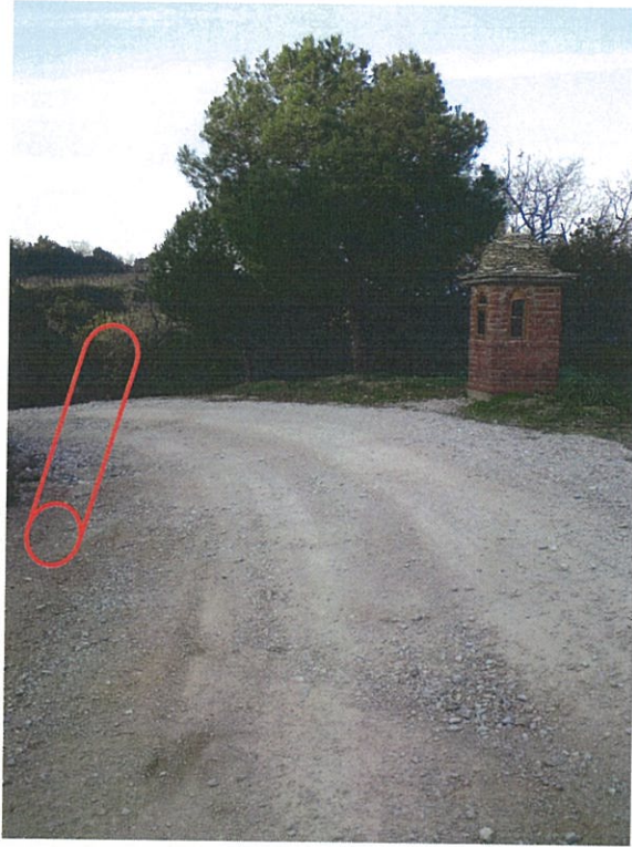
Φωτογραφία 9: Θέση προτεινόμενου τεχνικού 5 (σωληνωτός οχετός με φρεάτιο και περυγότοιχο, μήκους L=14\text{ m} , D=1\text{ m} ) στη διατομή αποτύπωσης. Το τεχνικό θα κατασκευαστεί στη διατομή \Delta\tau\Delta 27 .
