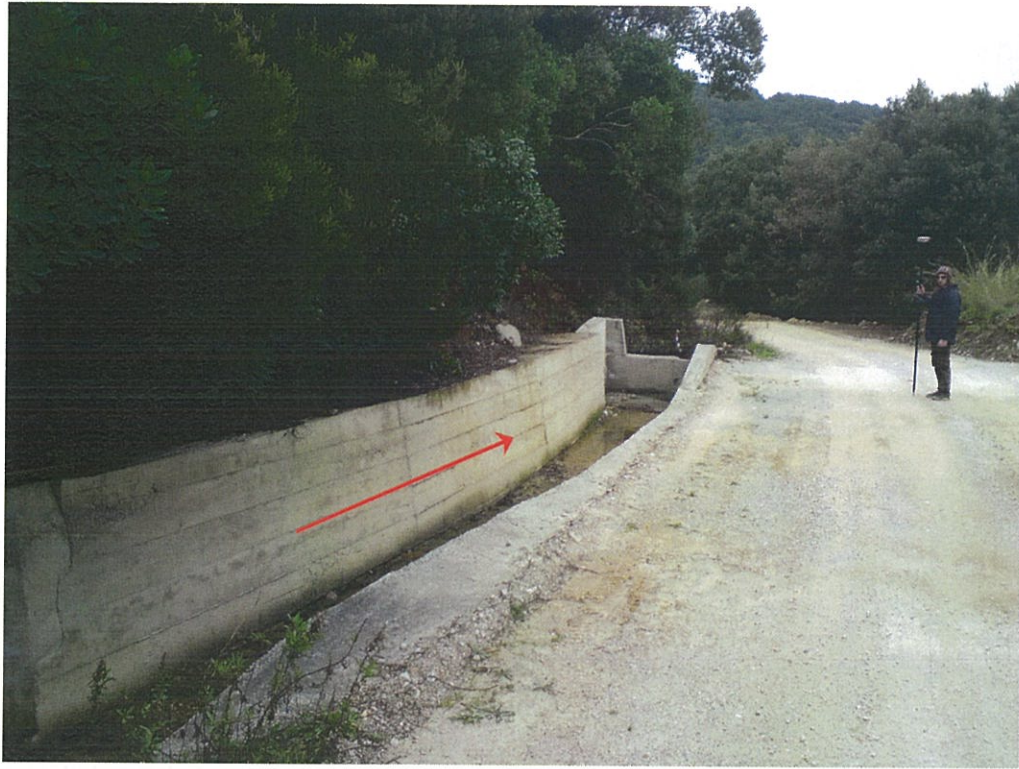
Φωτογραφία 7: Δτ Δ9. Υφιστάμενος σωληνωτός οχετός με φρεάτιο συλλογής ομβρίων και τσιμεντένια τάφρο.
