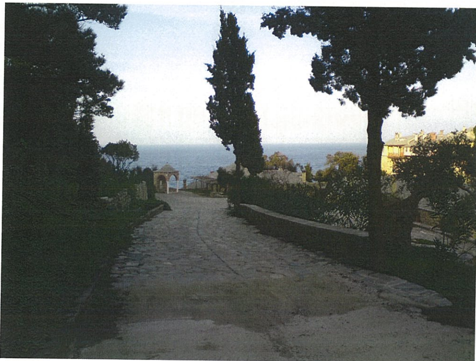
Φωτογραφία 10: Αρχή πλακόστρωτου προς πλατεία Ιεράς Μονής Σταυρονικήτα ( \Delta\tau_{\text{αποτ}} 142 ). Στη \Delta\tau_{\text{αποτ}} 138 ολοκληρώνονται οι χωματουργικές εργασίες και η οδοστρωσία της οδού. Από εκεί και μετά ο δρόμος είναι διαμορφωμένος με τιμεντοστρώσεις και λιθοστρώσεις και δεν επιδέχεται παρέμβασης.
