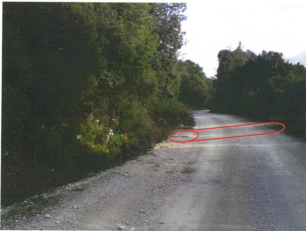
Φωτογραφία 8: Θέση προτεινόμενου τεχνικού 2 (σωληνωτός οχετός με φρεάτιο και περυγότοιχο, μήκους L=8\text{ m} , D=1\text{ m} ). Το τεχνικό θα κατασκευαστεί στη διατομή Δτ Δ17.
