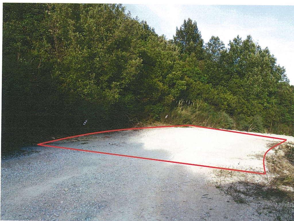
Φωτογραφία 4: Υφιστάμενο ρείθρο στη διατομή αποτύπωσης Δτ Δ5. Το τεχνικό αποτελεί μία από τις αναγκαστικές διαβάσεις, που λήφθηκαν υπόψη κατά τη σχεδίαση της προτεινόμενης κατάστασης.
