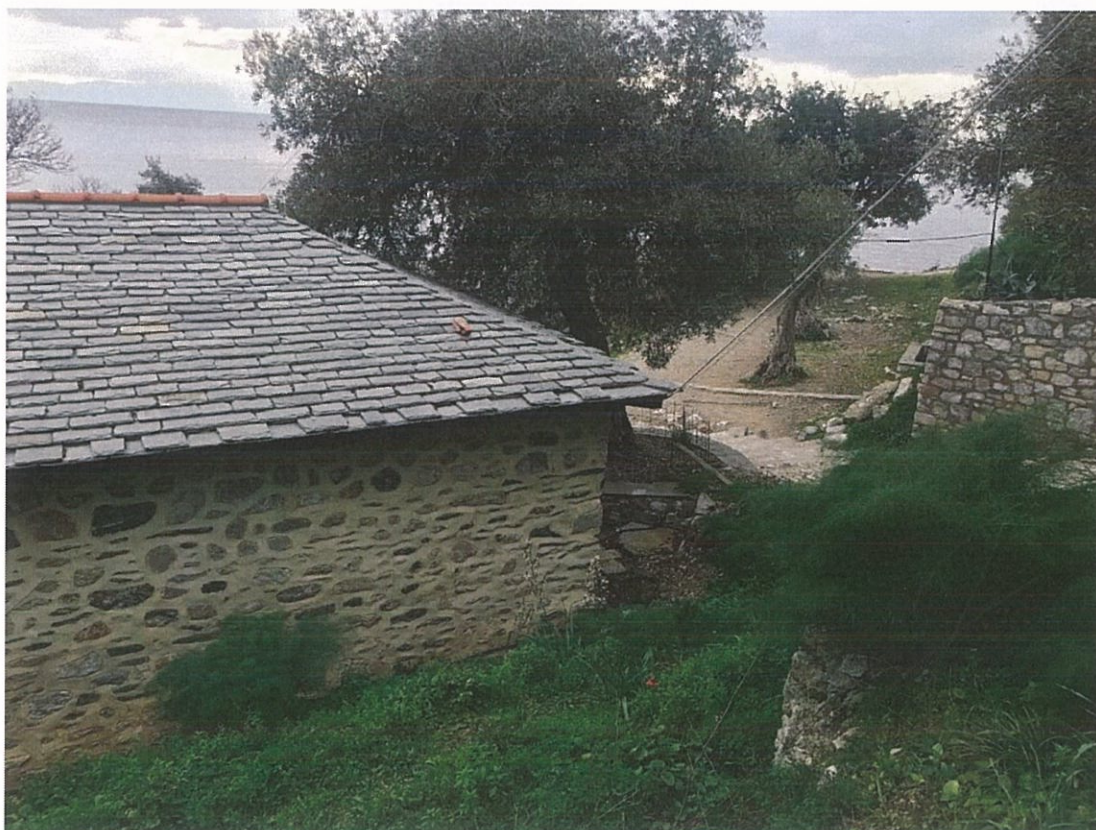
Εικ.4. Απεικόνιση της θέσης, κατασκευή της αποστραγγιστικής τάφρου, με μήκος 93,43m
