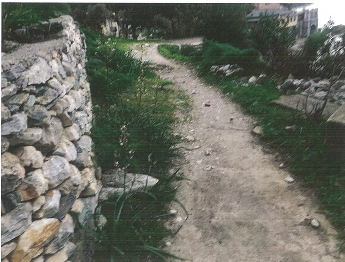
Εικ.3. Απεικόνιση της θέσης, κατασκευή της αποστραγγιστικής τάφρου, με μήκος 93,43m
