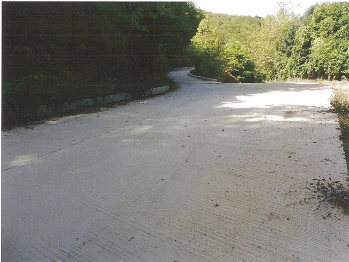
Εικ.4. Απεικόνιση της δασικής οδού ανάπτυξης του αγωγού Φ40 στην περιοχή «Κάγκελο»
