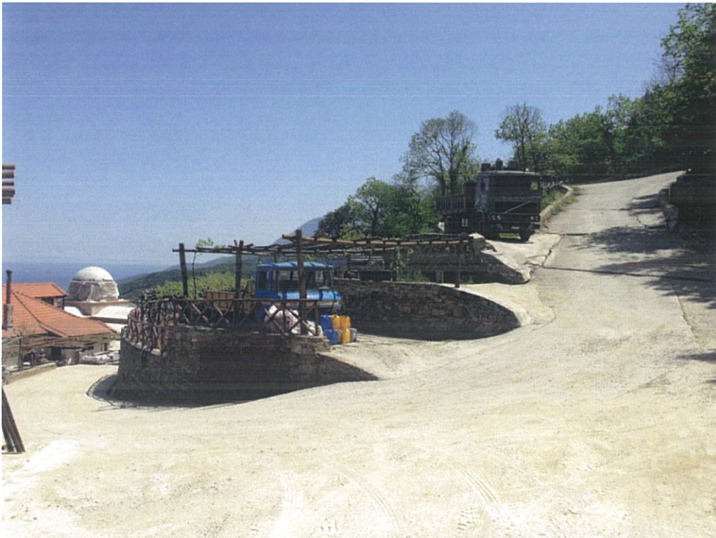
Εικ.4: Λήψη δυτικά του Κελλιού. Δεξιά, στον ανηφορικό δρόμο, διακρίνουμε δύο αναβαθμούς (!) που έχουν δημιουργηθεί λόγω των ρηγματώσεων και των καθιζήσεων του δρόμου από σκυρόδεμα. Καταδεικνύονται με τον πιο εμφανή τρόπο οι αλλοιώσεις του υπεδάφους λόγω των έντονων βροχοπτώσεων.
