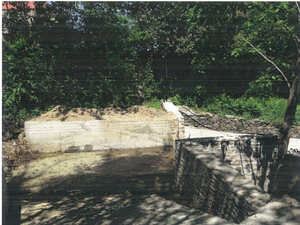
Εικ.6: Το ημιτελές κανάλι βόρεια του Κελλιού. Η ολοκλήρωσή του θα συμβάλει δραματικά στην παραλαβή του μεγαλύτερου όγκου του νερού του ρέματος (που ξεκινά από ψηλά – δυτικά) καθώς και των βρόχινων νερών που μπορούν μέσω των ποικίλων αυλακώσεων να διοχετεύονται στο εν λόγω κανάλι.
