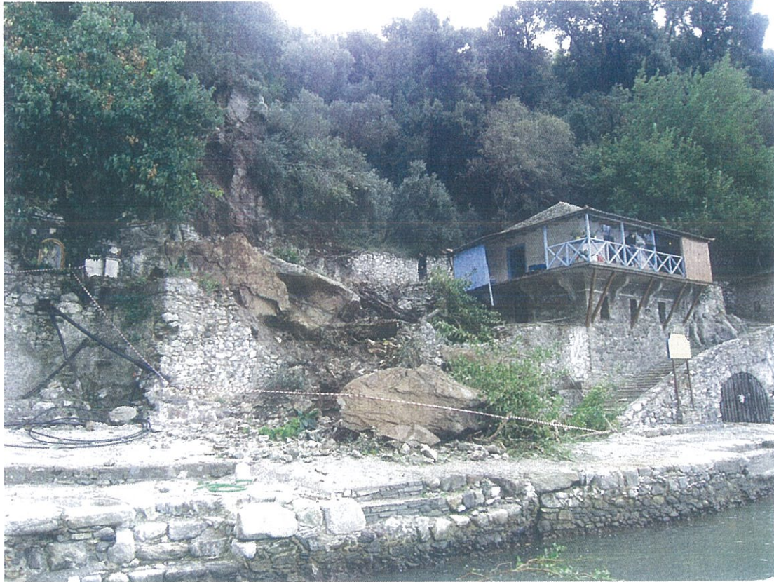
Φωτογραφία 3: Άποψη της περιοχής της εκδηλωθείσας κατολίσθησης (Οκτ. 2006)
