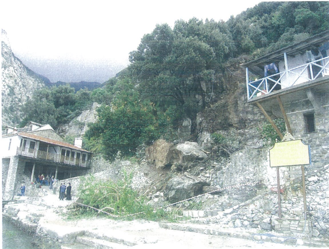
Φωτογραφία 2: Χαρακτηριστική άποψη του τμήματος της Μονής που επλήγη από την εκδηλωθείσα κατολίσθηση (Οκτ. 2006)
