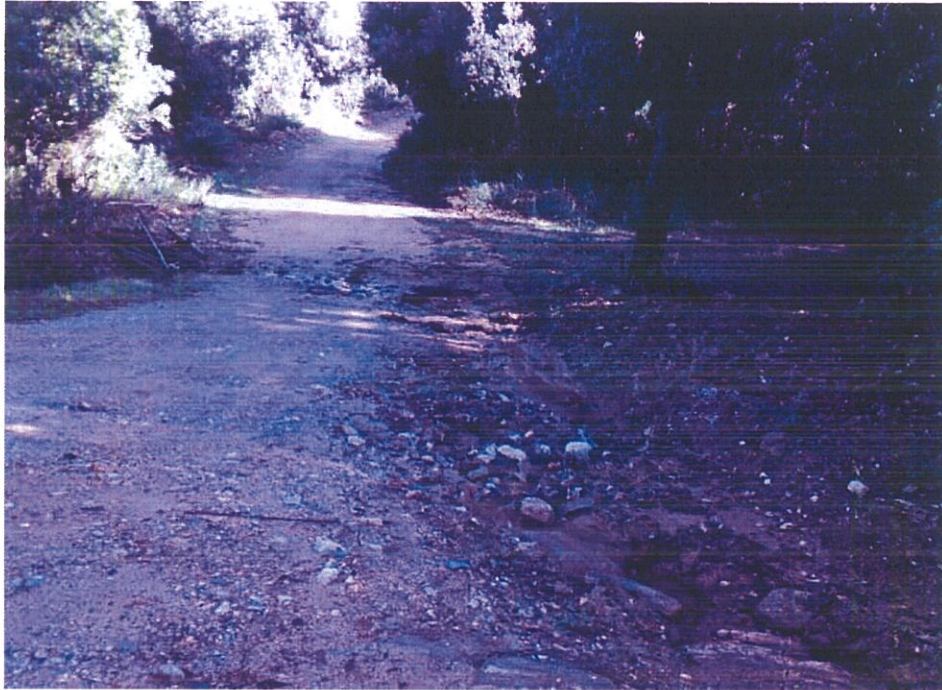
Φωτογραφία 3. Θέση κατασκευής TE4
