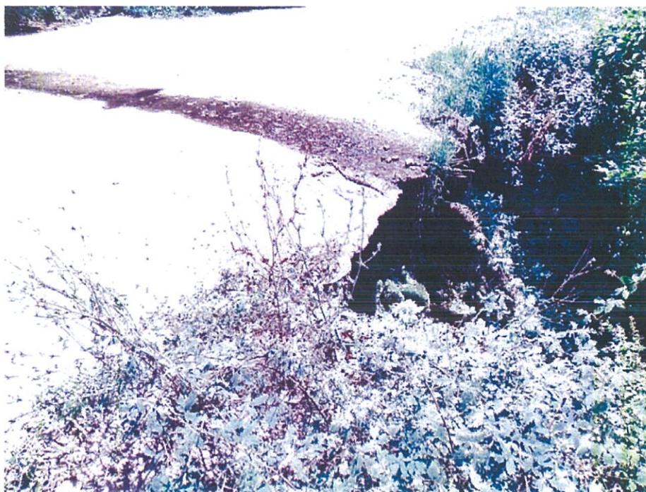
Φωτογραφία 7. Θέση κατασκευής λιθοδομής
