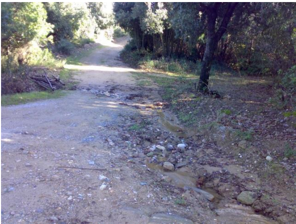
Εικόνα 3. Θέση κατασκευής TE4
