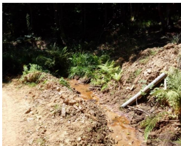
Εικόνα 6. Θέση κατασκευής TE5
