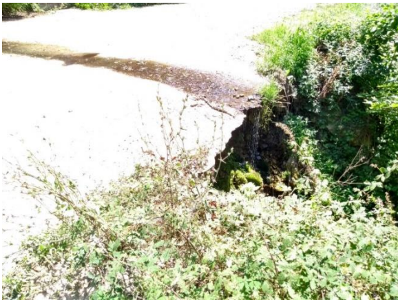
Εικόνα 8. Θέση κατασκευής λιθοδομής
