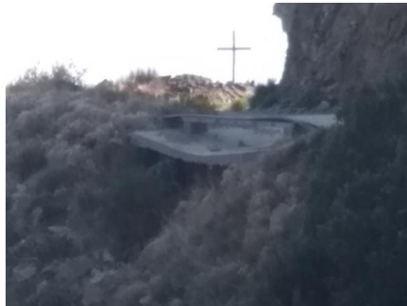
Εικόνα 9. Θέση κατασκευής λιθοδομής
