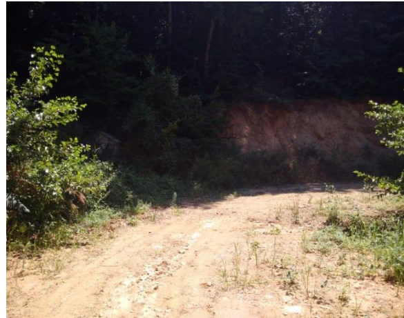
Εικόνα 2. Θέση κατασκευής TE3
