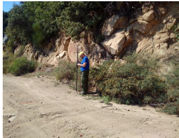
Εικόνα 4. Θέση κατασκευής TE6
