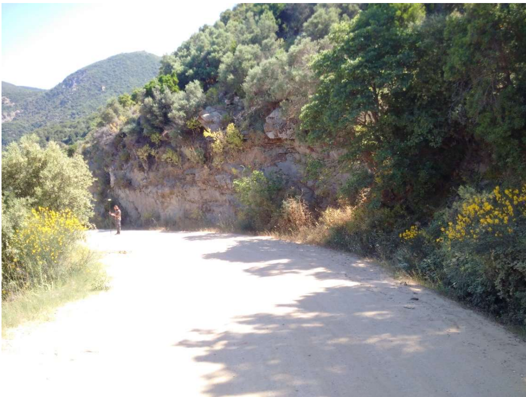
Φωτογραφία 16. Θέση κατασκευής ρείθρου και τσιμεντένιας τάφρου (TE16)
