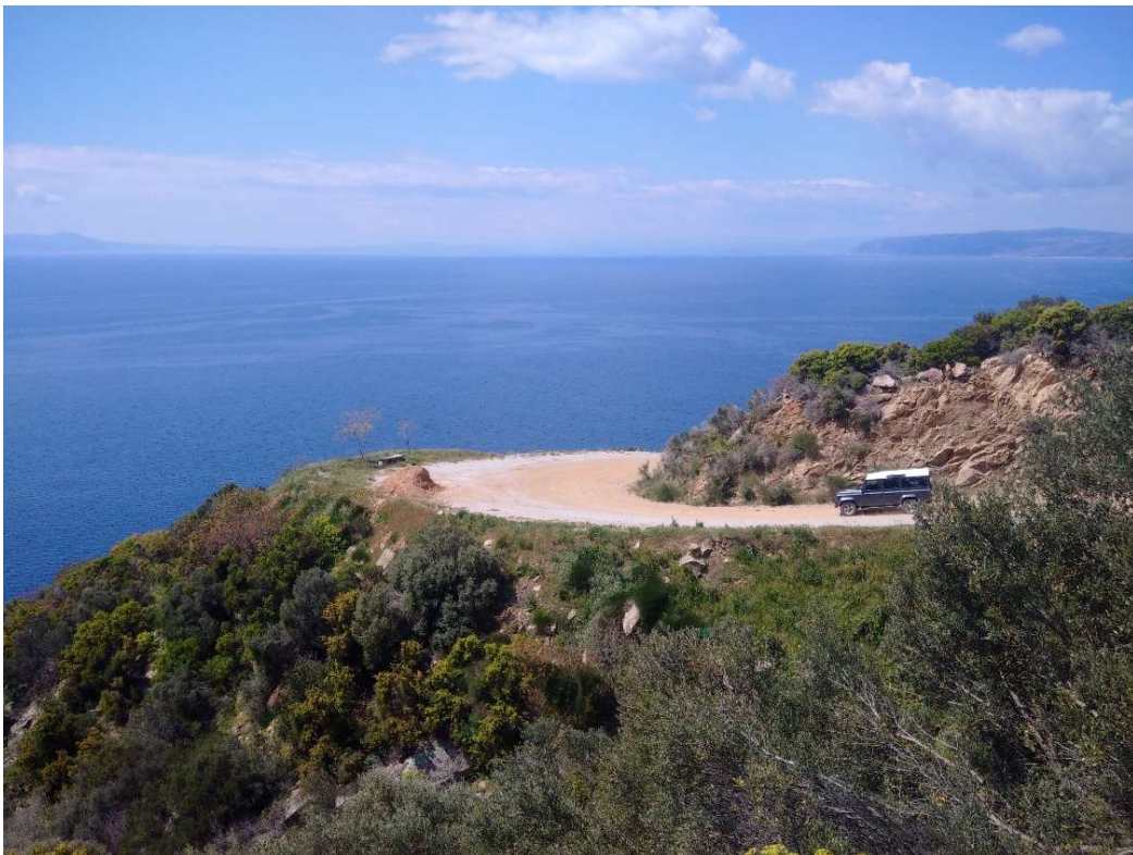
Φωτογραφία 14. Θέση κατασκευής στηθαίων, τσιμεντόστρωσης και τσιμεντένιας τάφρου (TE14)
