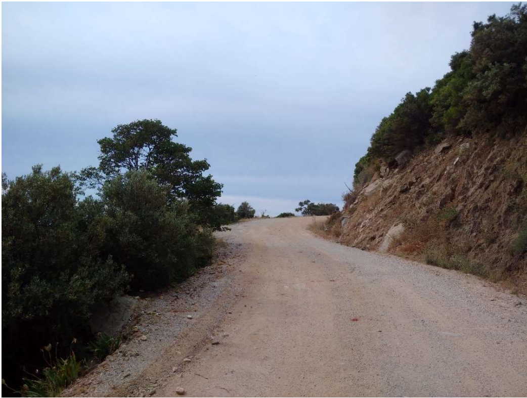
Φωτογραφία 11. Θέση κατασκευής σωληνωτού οχετού (TE11)
