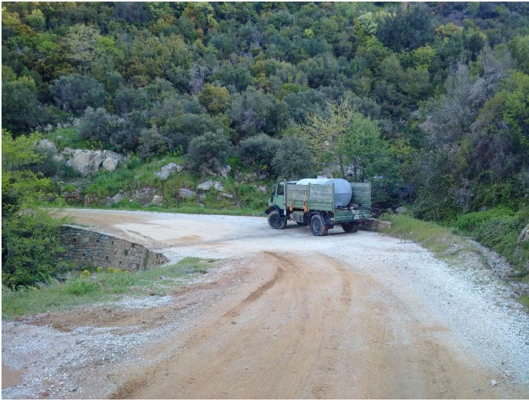
Φωτογραφία 7. Θέση κατασκευής στηθαίων (TE7)
