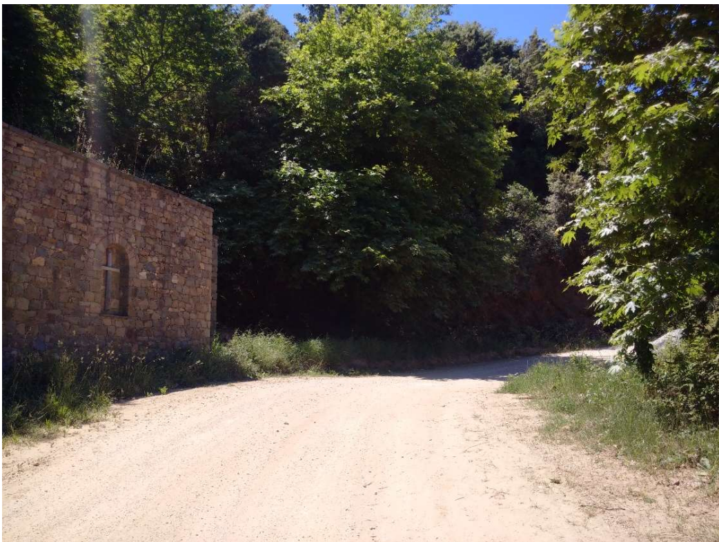
Φωτογραφία 18. Θέση κατασκευής σωληνωτού οχετού, τσιμεντόστρωσης και στηθαίου (TE18)
