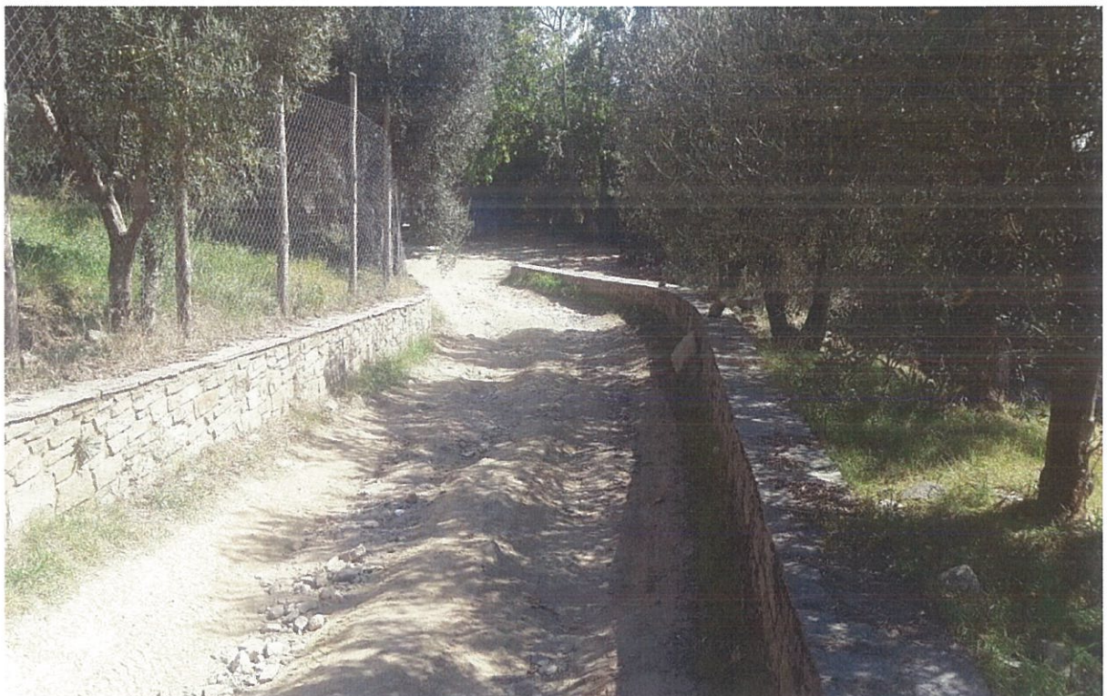
Εικόνα 3.8: Απεικόνιση τμήματος της τοπικής οδού προς βελτίωση «Μοναστήρι – Ι.Κ. Αγίων Αναργύρων – Νέα Δεξαμενή», από Χ.Θ. 0+022,00χλμ. (με φορά προς την αφετηρία).
