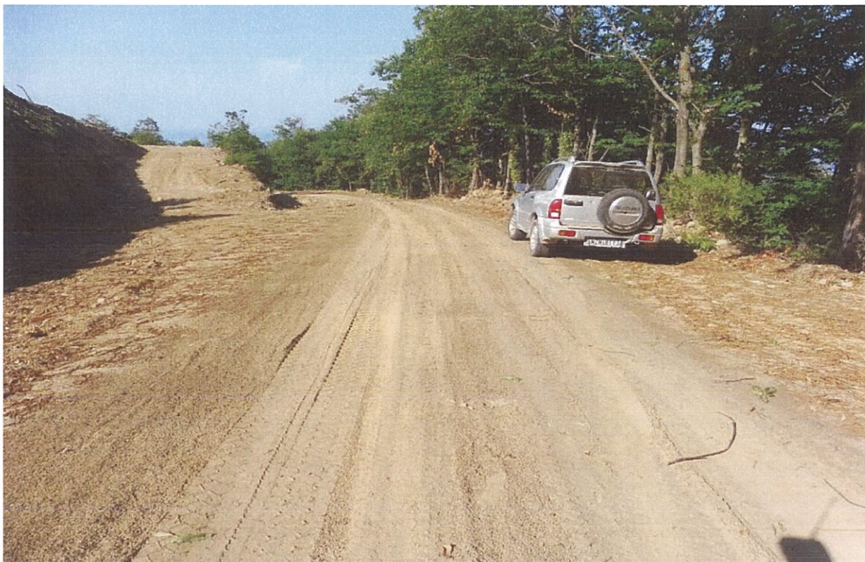
Εικόνα 3.6 Απεικόνιση της δασικής οδού "Μοναστήρι-Μεταμόρφωση-Σοφονιάς", στη θέση κατασκευής του τεχνικού (T21)
