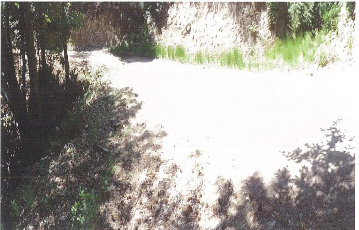
Εικόνα 3.11 Απεικόνιση της δασικής οδού "Κρέβατος-Κάγκελο", στη θέση κατασκευής του τεχνικού (Τ9)
