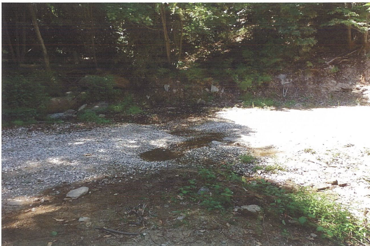
Εικόνα 3.9 Απεικόνιση της δασικής οδού "Κρέβατος-Κάγκελο", στη θέση κατασκευής του τεχνικού (Τ1)
