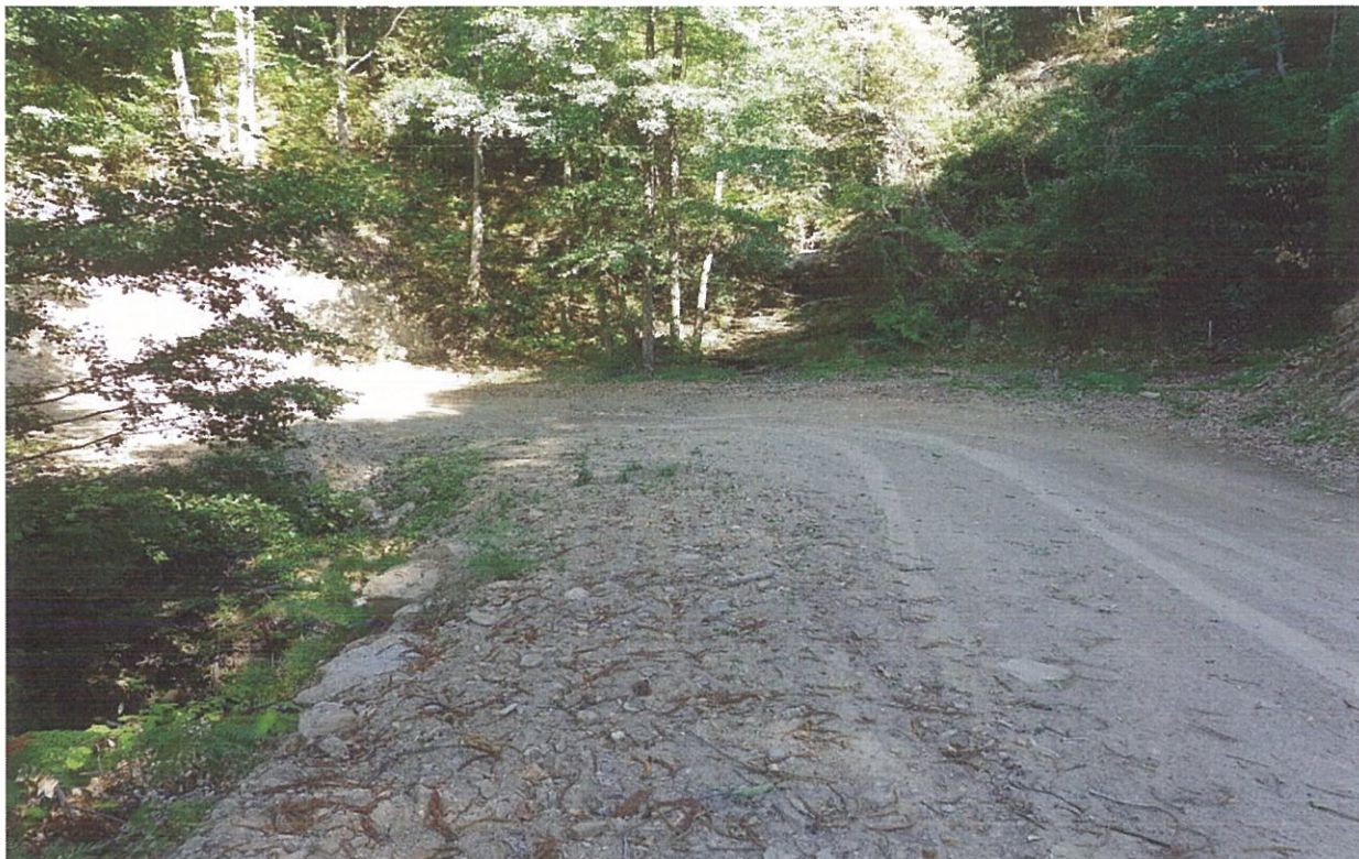
Εικόνα 3.8 Απεικόνιση της δασικής οδού "Μοναστήρι-Μεταμόρφωση-Σοφονιός", στη θέση κατασκευής του τεχνικού (Τ28)
