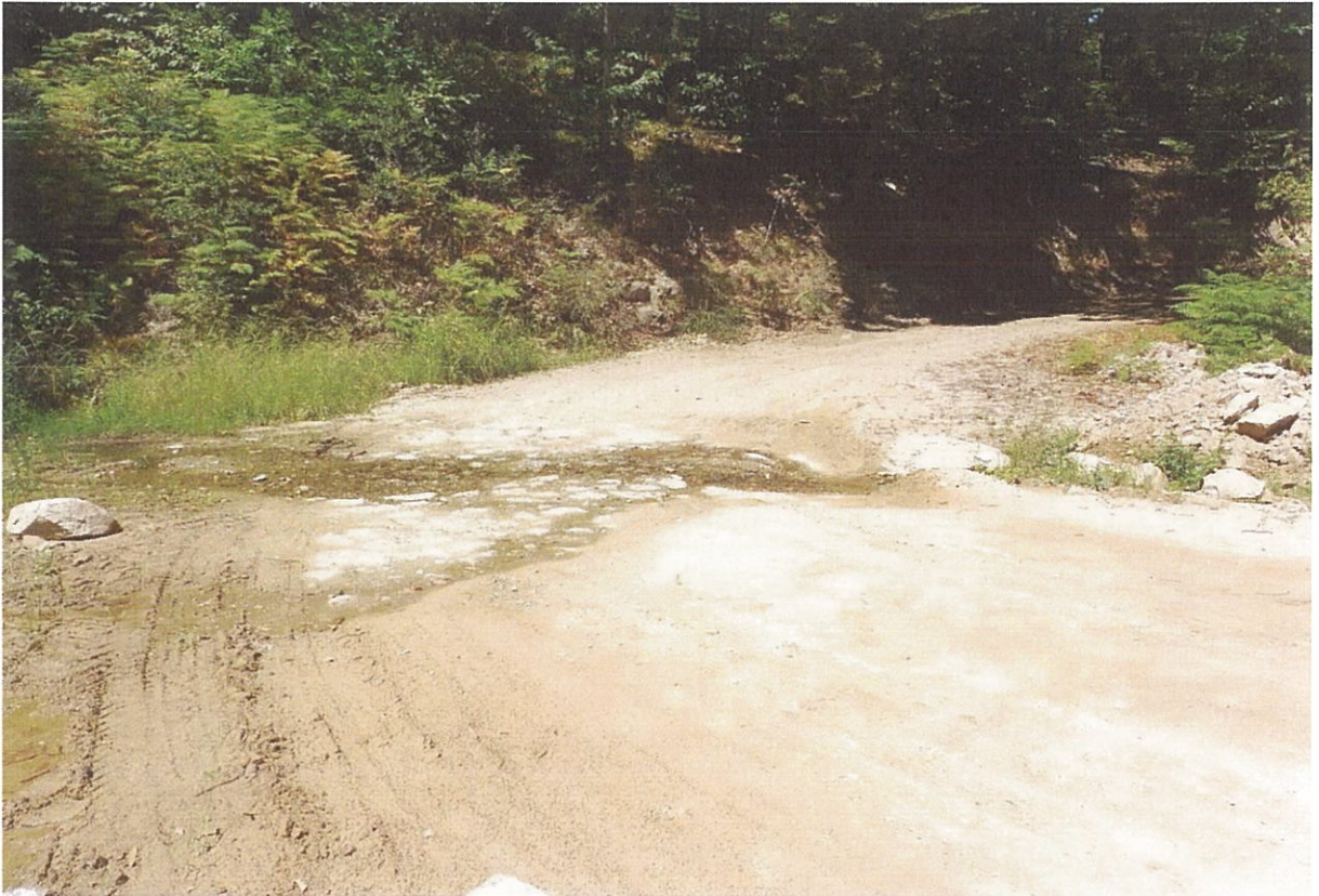
Εικόνα 3.10 Απεικόνιση της δασικής οδού "Κρέβατος-Κάγκελο", στη θέση κατασκευής του τεχνικού (Τ8)
