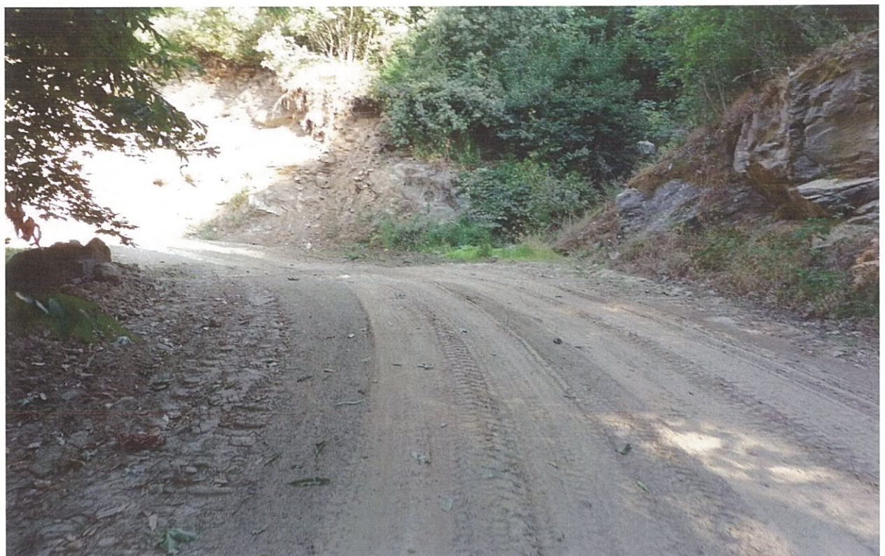
Εικόνα 3.5 Απεικόνιση της δασικής οδού "Μοναστήρι-Σπηλιά Αγ. Διονυσίου", στη θέση κατασκευής του τεχνικού (T18)
