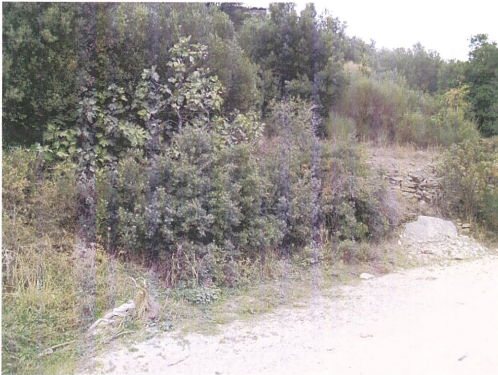
Φωτογραφία 1. Περιοχή κατασκευής δεξαμενής
