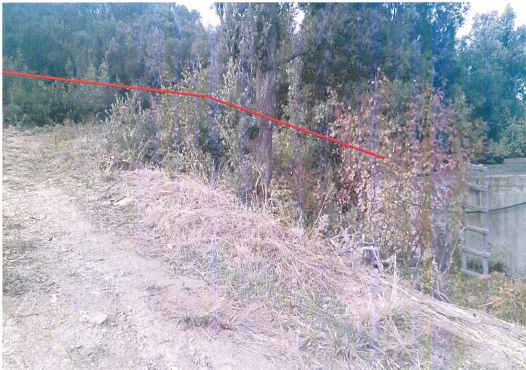
Φωτογραφία 4. Δεξαμενή Πόσιμου ύδατος & άρδευσης 100m 3 Αμπελιού
