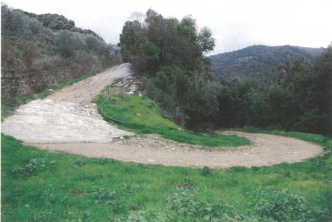
Εικ. 4: Προβολή της δασικής οδού Πηγές - Σκήτη, σε ελιγμό κατόντη της Σκήτης Προφήτη Ηλία. Στο κατάστρωμα αυτής απεικονίζεται ο αγωγός Φ90mm, ο οποίο έχει ανοιχτεί προσωρινά, λόγω φραγμού του υφιστάμενου εγκιβωτισμένου δικτύου ύδρευσης από ΡΕ.
