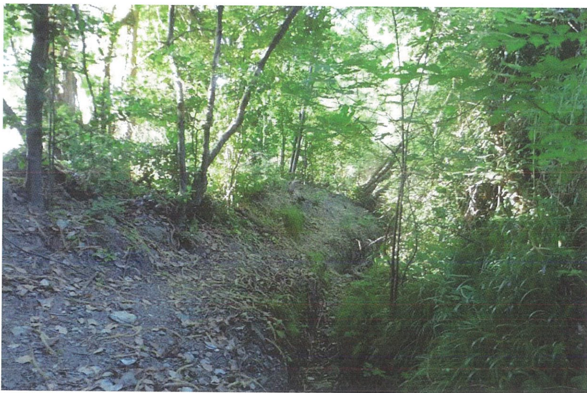
Εικόνα 15: Απεικόνιση υφιστάμενης τάφρου η οποία καταλήγει στη πλαστική δεξαμενή στην θέση «Ι.Κ. Ευαγγελισμού», και θα αποτελέσει τμήμα της όδευσης του νέου αγωγού με ονομαστική διάμετρο Φ63.
