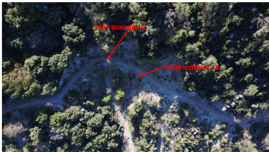
Εικόνα 17: Δορυφορική εικόνα θέσεων αστοχίας 1Β και 1Γ
