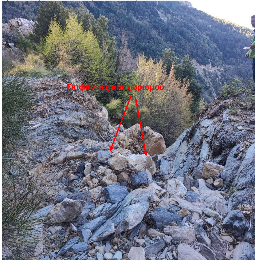
Εικόνα 20: Θέση αστοχίας δομικού χαρακτήρα στην περιοχή μελέτης 2.
