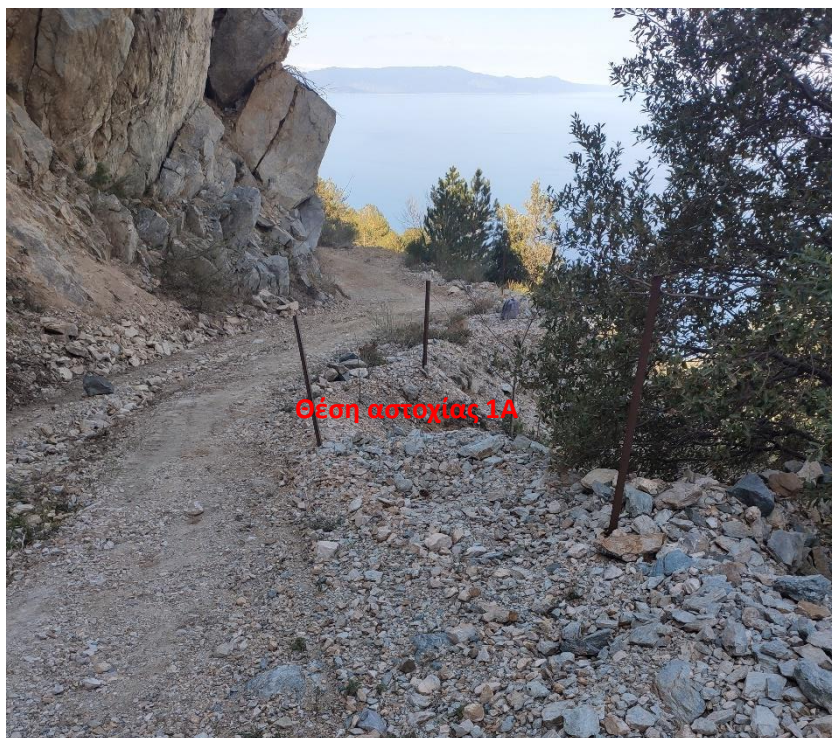
Εικόνα 14: Θέση αστοχίας 1Α.
