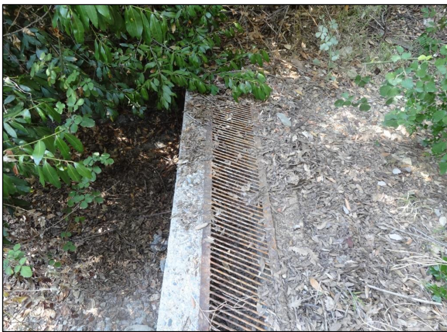
Φωτ. 1 : Φρεάτιο εισόδου στην θέση του ρέματος.
