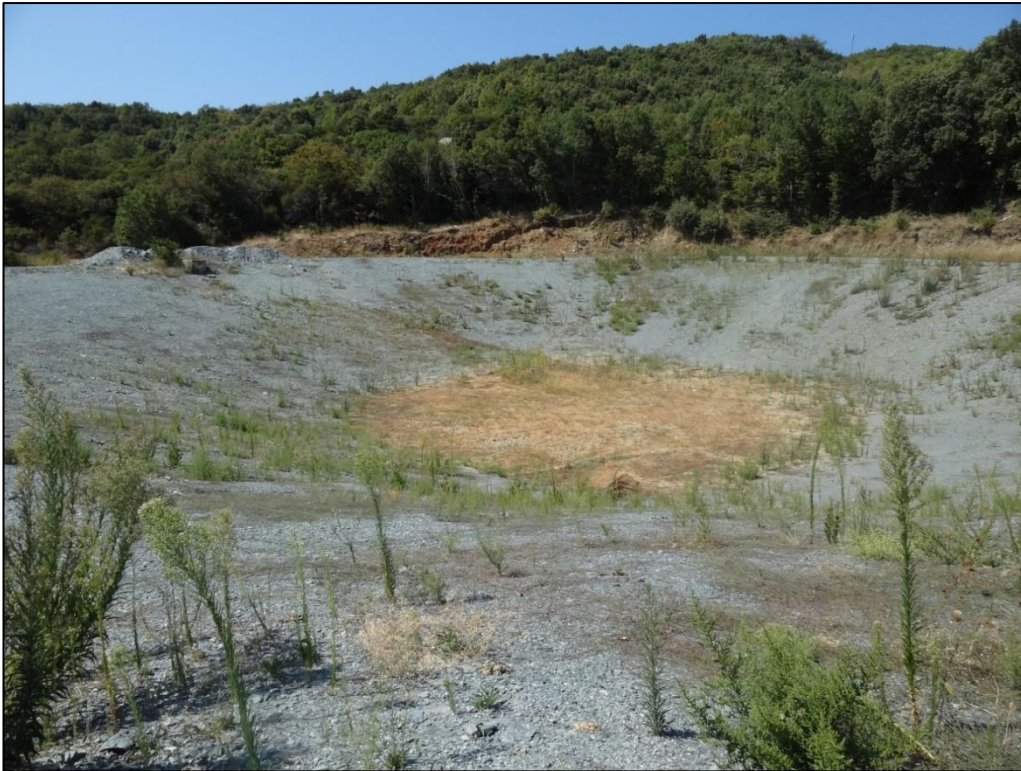
Φωτ. 3 : Υφιστάμενη λιμνοδεξαμενή.
