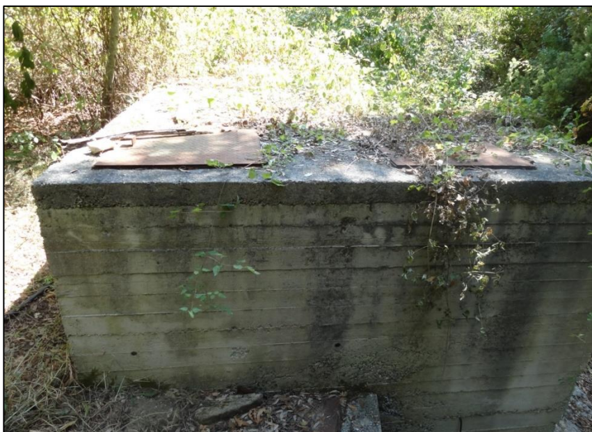
Φωτ. 2 : Φρεάτιο υδροληψίας στην θέση του ρέματος.
