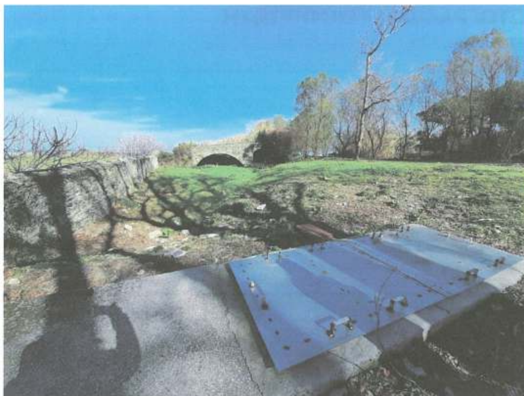
Χώρος κατασκευής Ε.Ε.Λ. με υφιστάμενο φρεάτιο συλλογής λυμάτων
