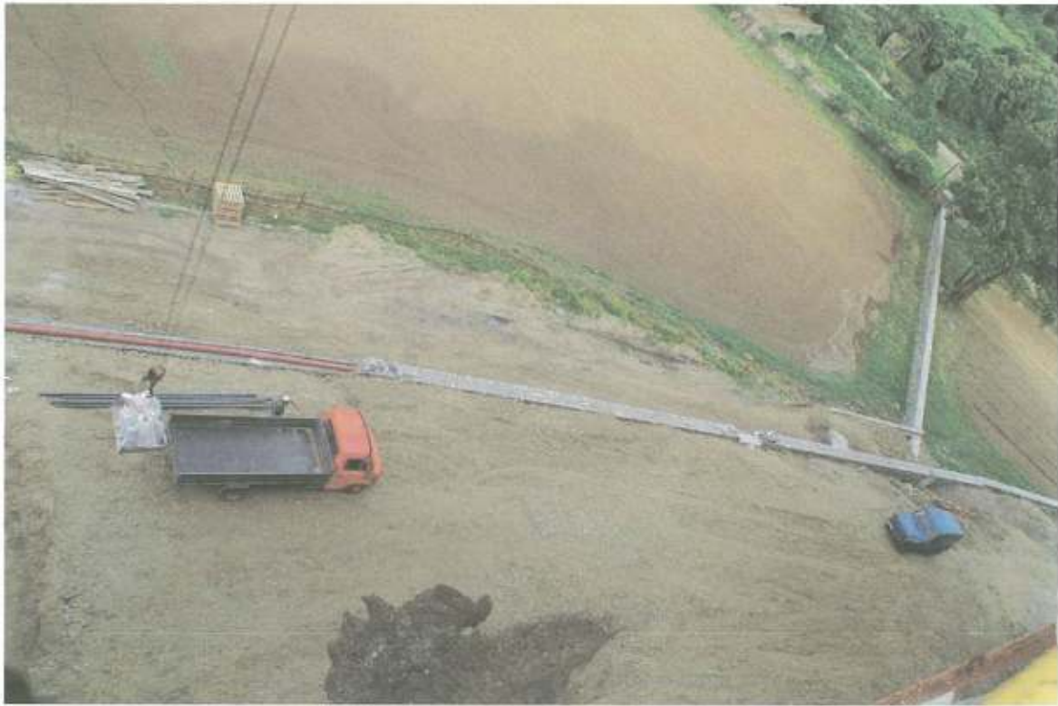
Έργο κατασκευής υφιστάμενων αγωγών προσαγωγής λυμάτων
