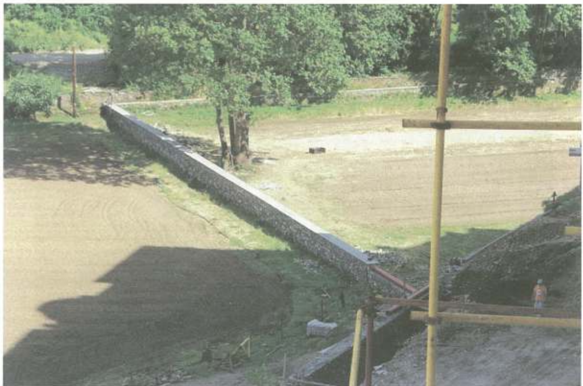
Έργο κατασκευής υφιστάμενων αγωγών προσαγωγής λυμάτων
