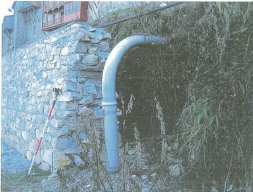
Αρχή νέου αγωγού από βόρεια πλευρά
