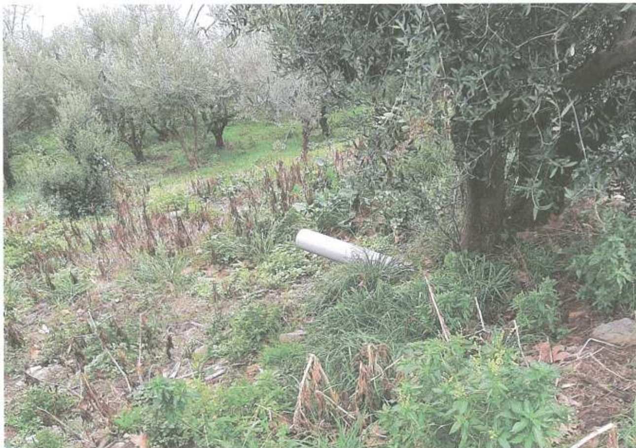
Χώρος κατασκευής Ε.Ε.Λ.
