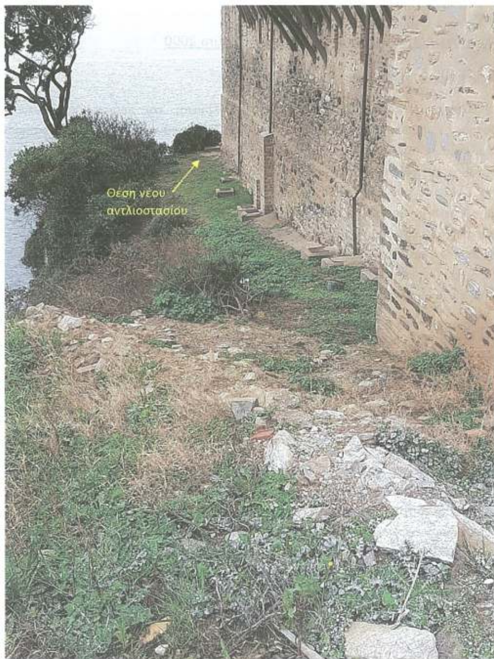
Φωτογραφία 3: Περιοχή όδευσης καταθλιπτικού αγωγού προσαγωγής λυμάτων και θέση αντλιοστασίου λυμάτων βορειοανατολικής απόληξης
