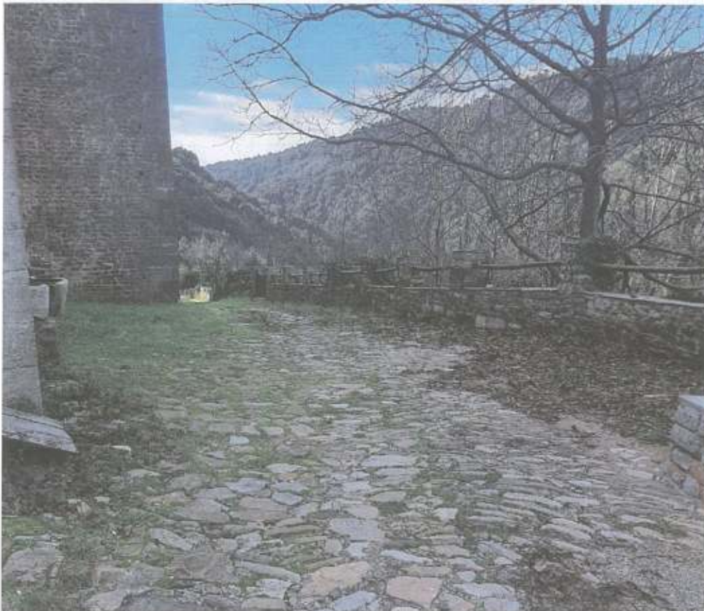
Οδός όδευσης υφιστάμενου συλλεκτήριου αγωγού αποχέτευσης
