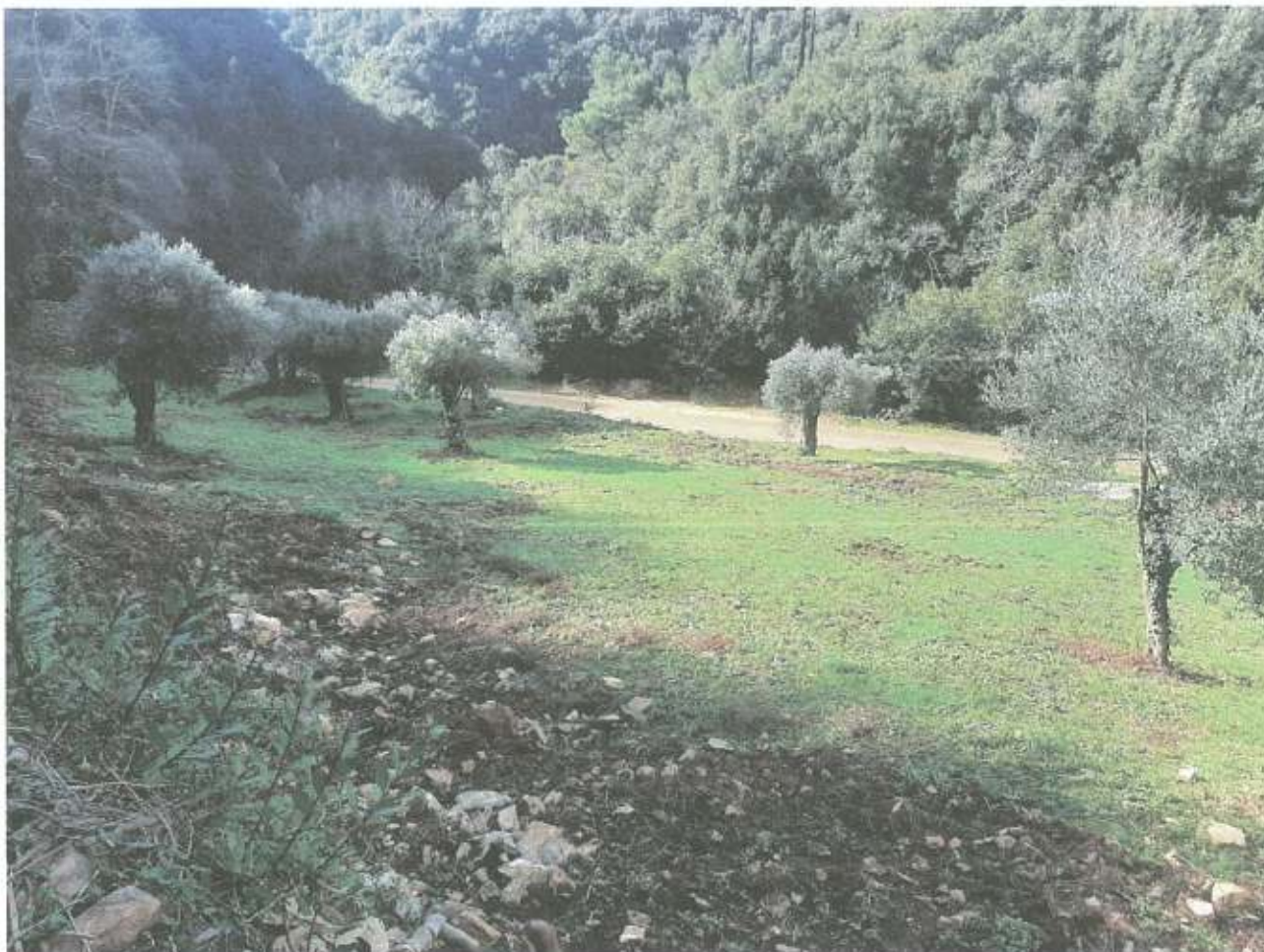
Χώρος κατασκευής Ε.Ε.Λ.
