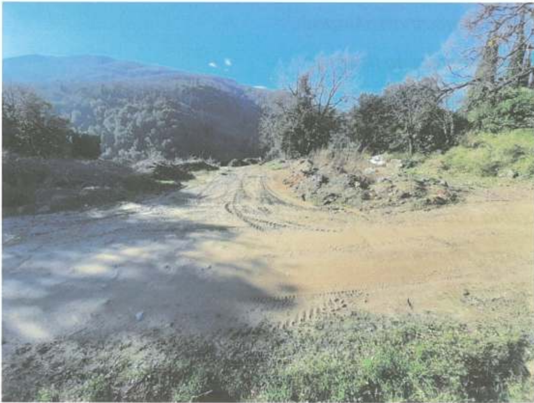
Χώρος κατασκευής Ε.Ε.Λ.
