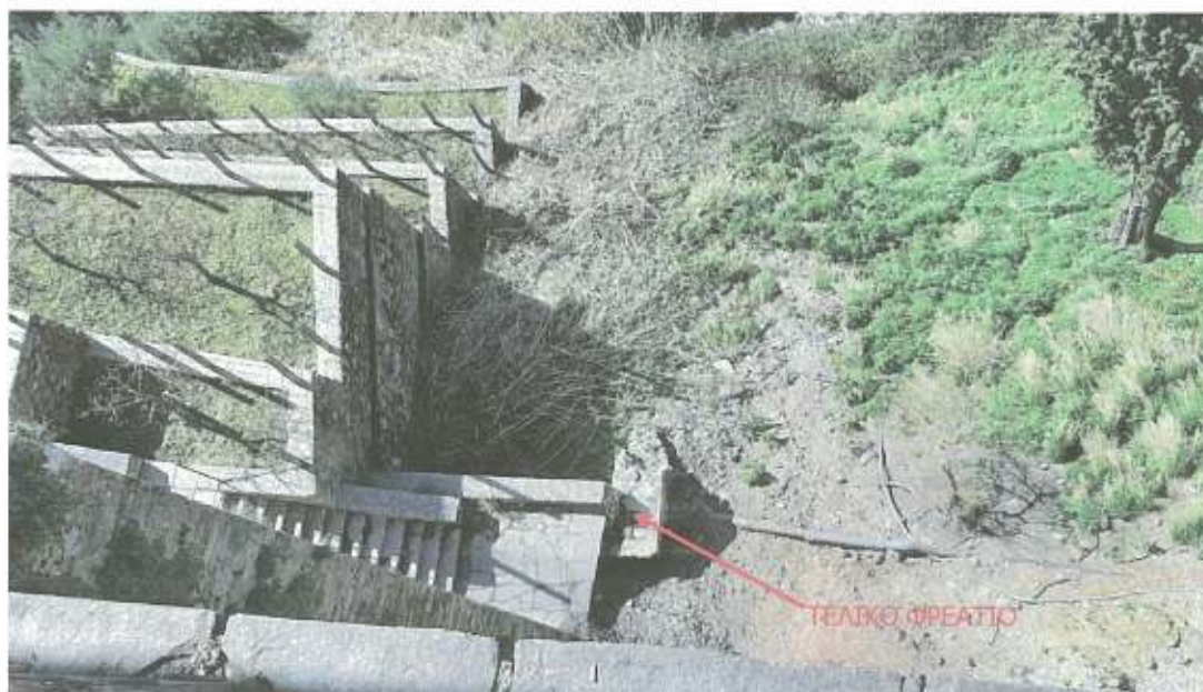
Τελικό φρεάτιο συλλογής λυμάτων
