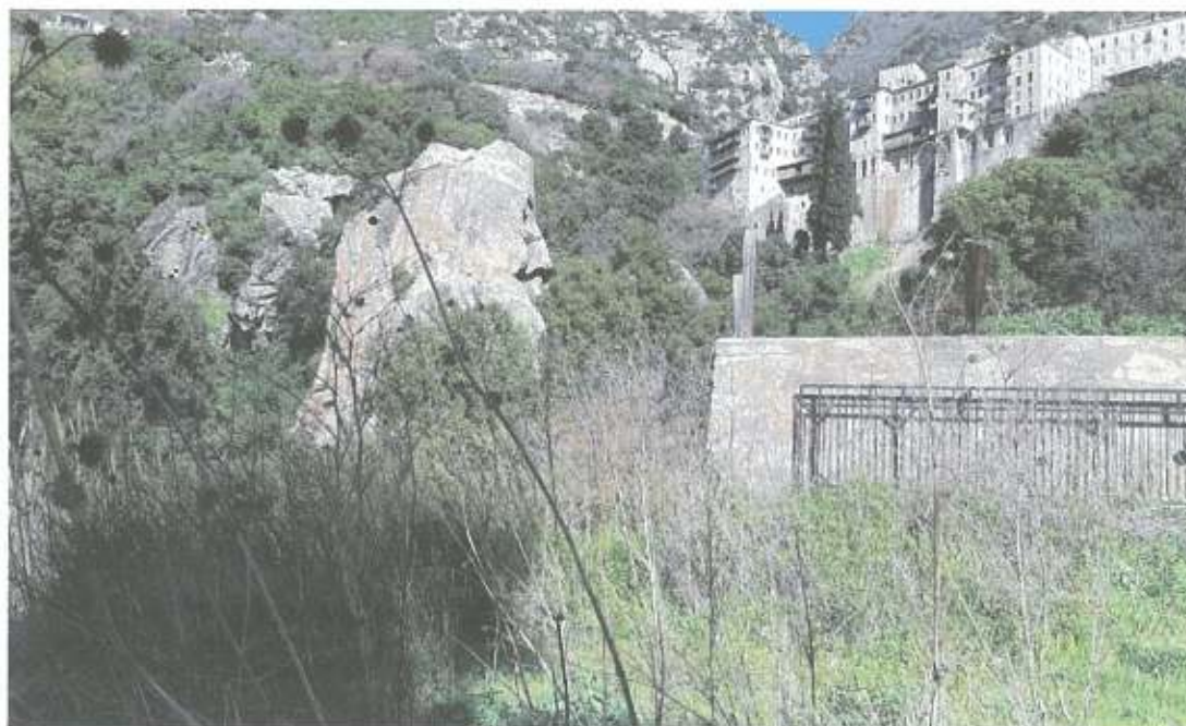
Χώρος κατασκευής Ε.Ε.Λ.
