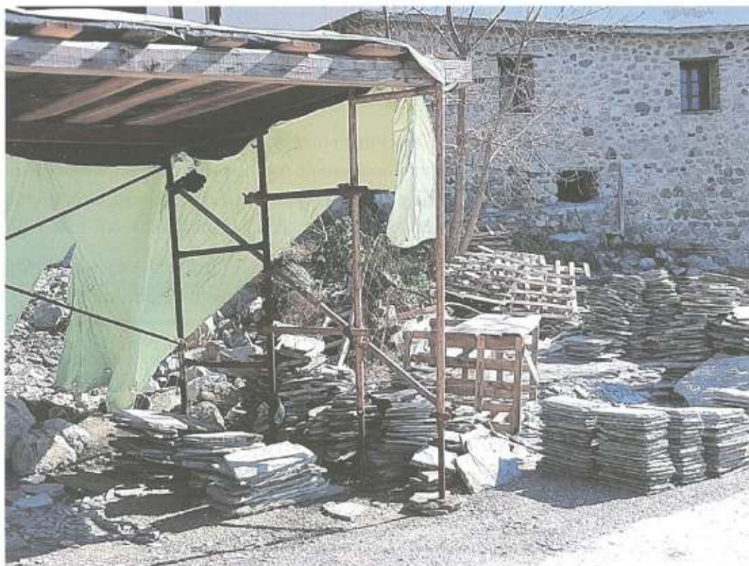
Φωτογραφία 1: Θέση χώρου κατασκευής Ε.Ε.Λ. 1
