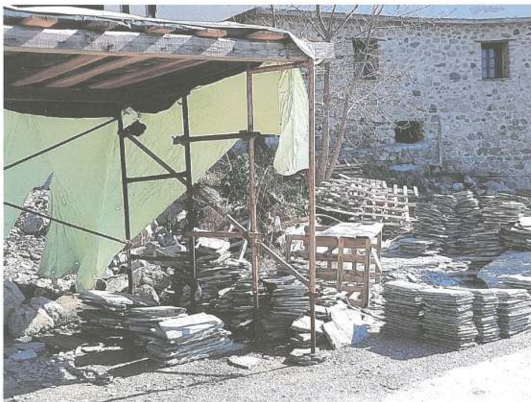
Θέση χώρου κατασκευής Ε.Ε.Λ. 1
