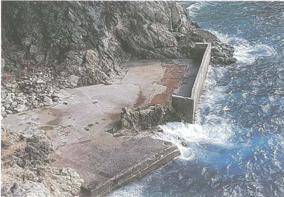
Θέση χώρου κατασκευής Ε.Ε.Λ. 3
