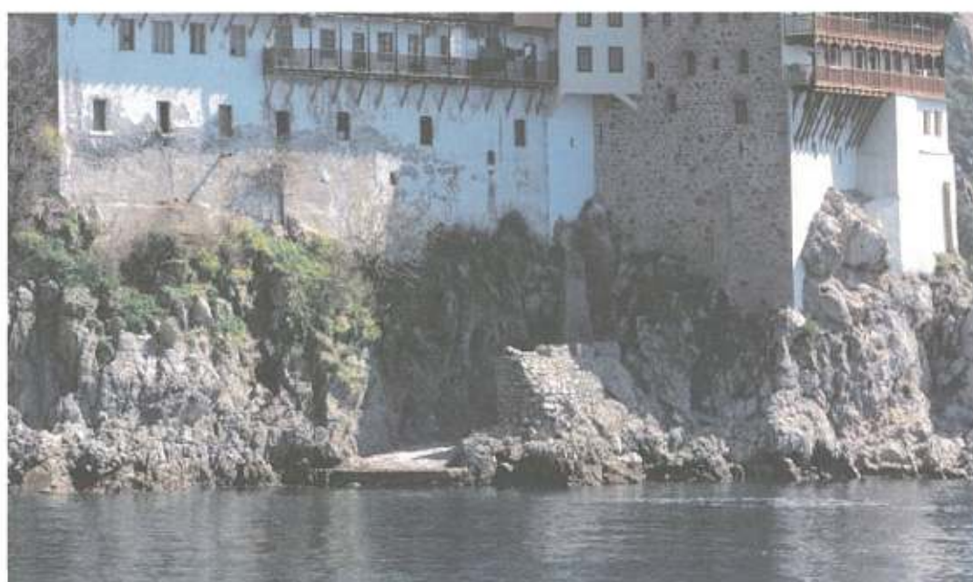
Φωτογραφία 2: Θέση χώρου κατασκευής Ε.Ε.Λ. 2
