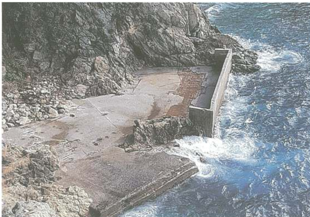
Φωτογραφία 3: Θέση χώρου κατασκευής Ε.Ε.Λ. 3
