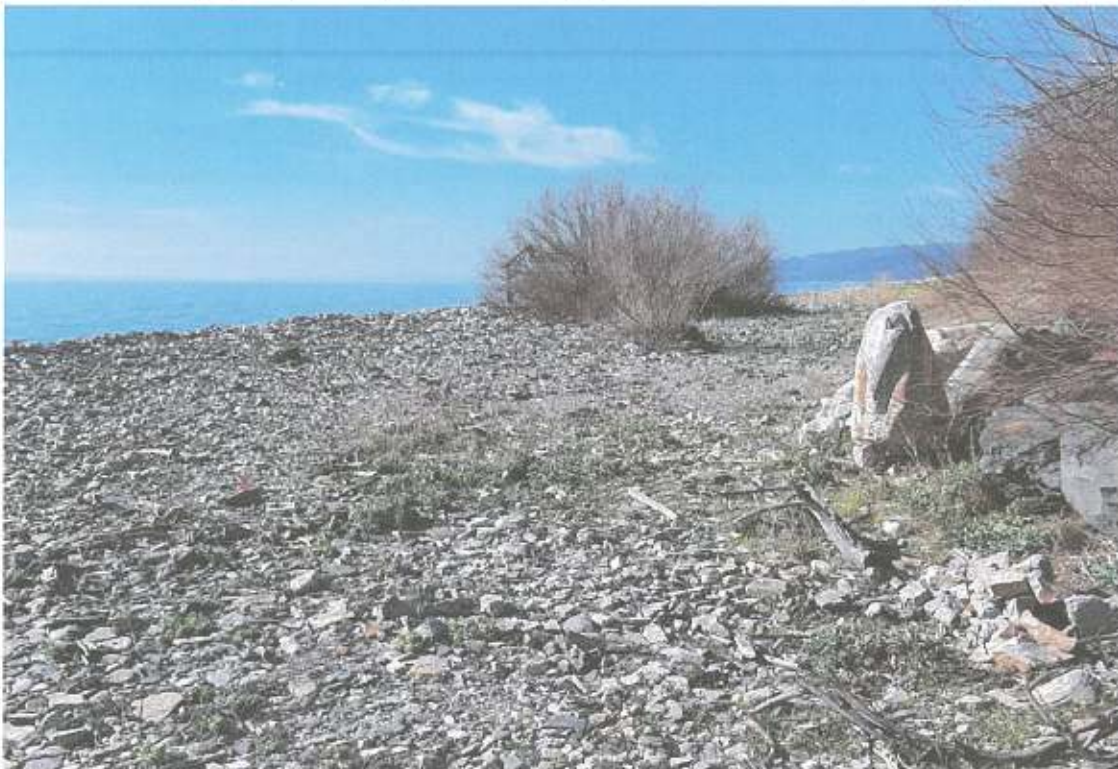
Χώρος κατασκευής Ε.Ε.Λ.
