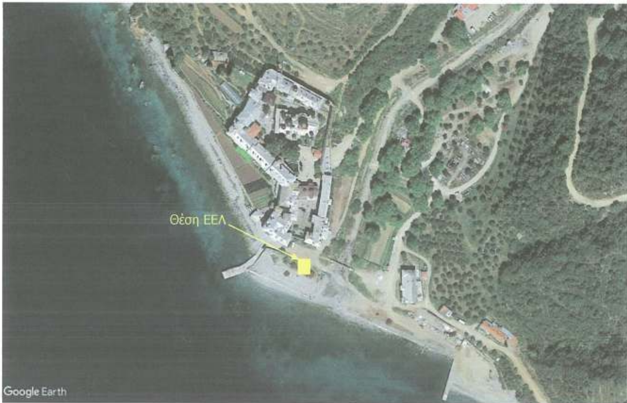
Απόσπασμα δορυφορικής εικόνας θέσης έργου
