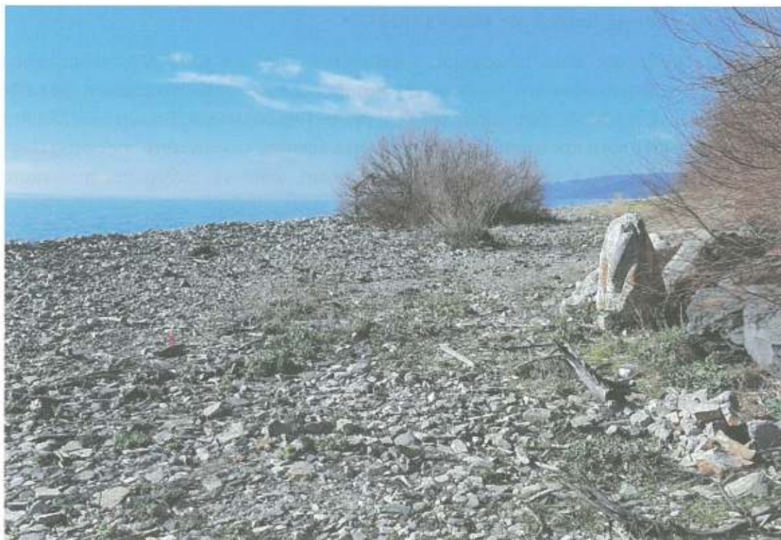
Φωτογραφία 2: Χώρος κατασκευής Ε.Ε.Λ.
