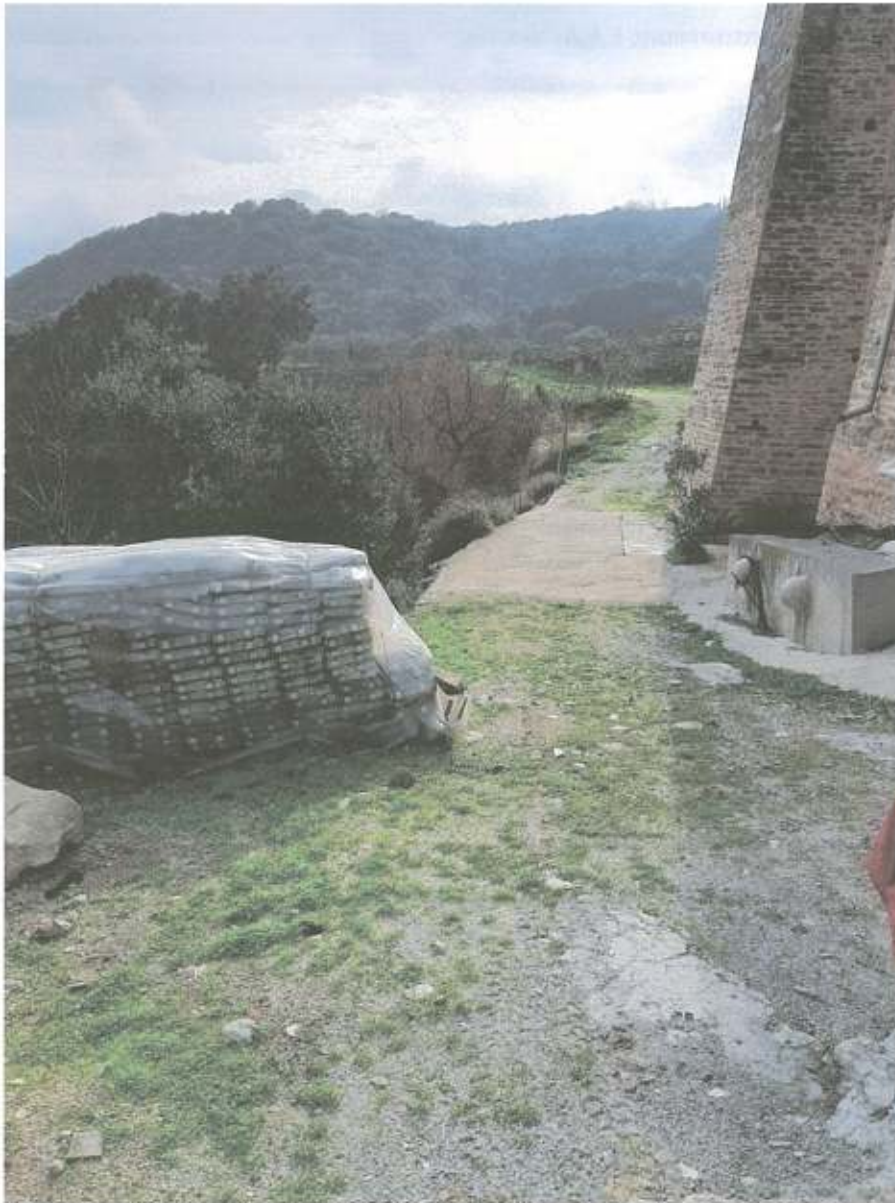
Φωτογραφία 3: Θέση αντλιοστασίου ανατολικής απόληξης
