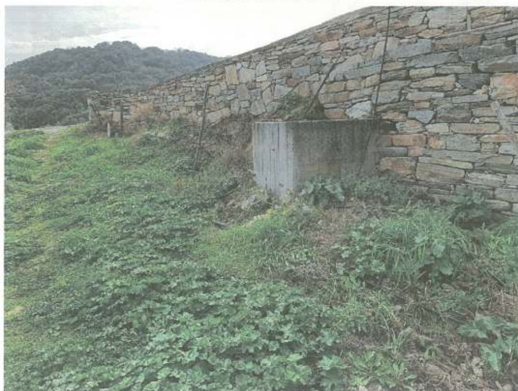
Υφιστάμενο φρεάτιο δυτικής απόληξης
