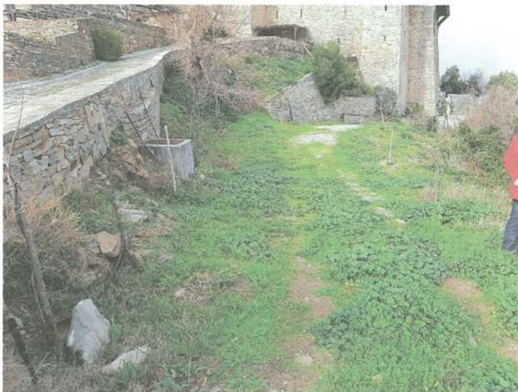
Χώρος κατασκευής Ε.Ε.Λ.
