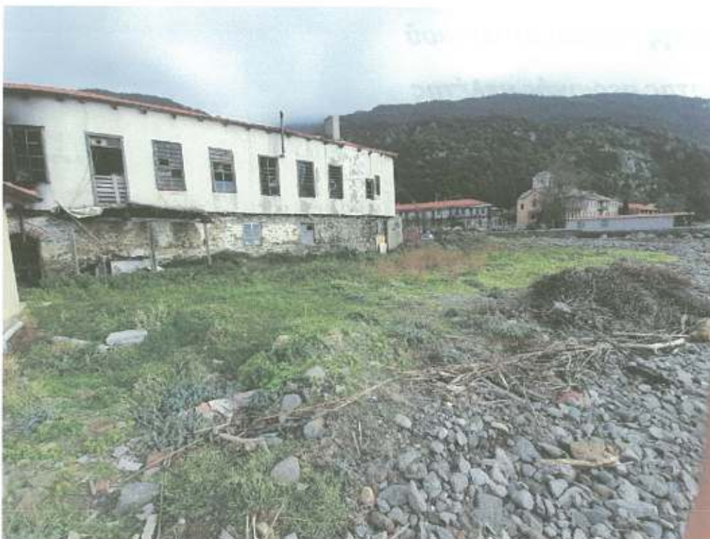
Χώρος κατασκευής Ε.Ε.Λ.
